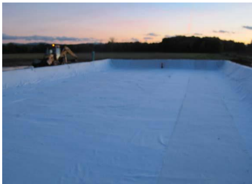
Ilustración 30. Humedal de flujo Subsuperficial en construcción
