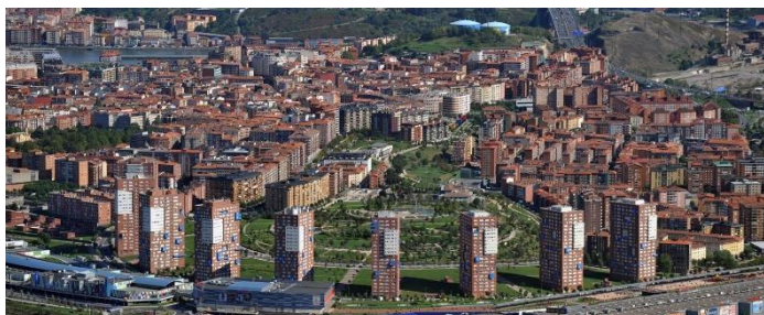
San Vicente auzoa. Iturria: Bilbaoenconstrucciones.com
