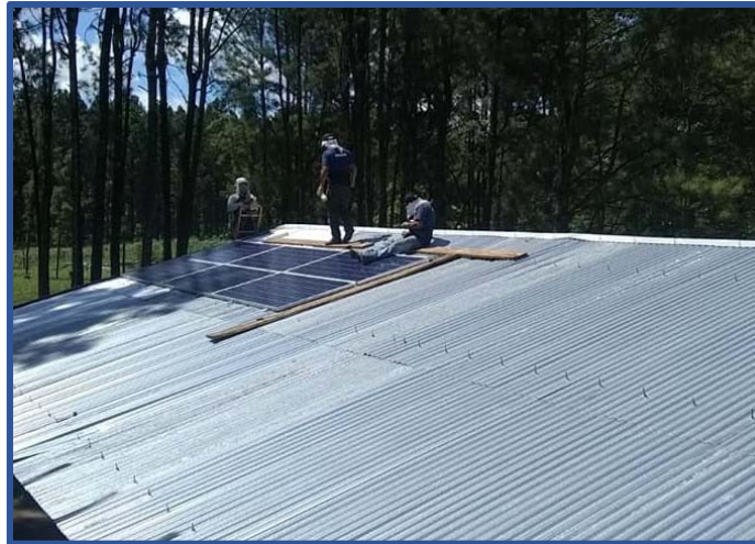
Ilustración 23: Instalación de los paneles solares
