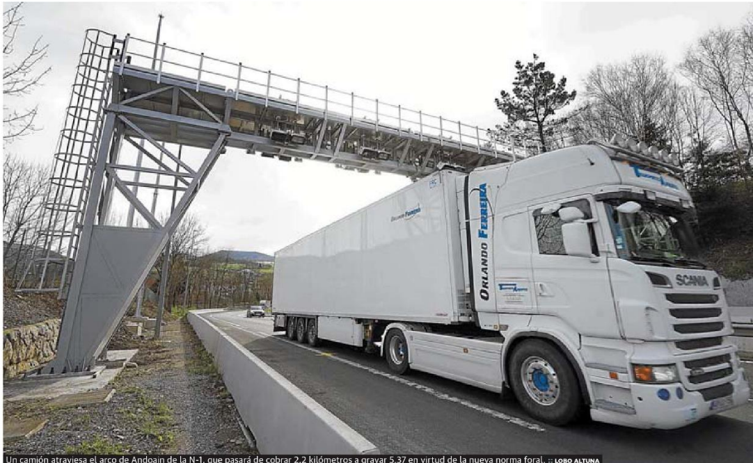
Un camión atraviesa el arco de Andoain de la N-1, que pasará de cobrar 2,2 kilómetros a gravar 5,37 en virtud de la nueva norma foral. -- LOBO ALTUNA
