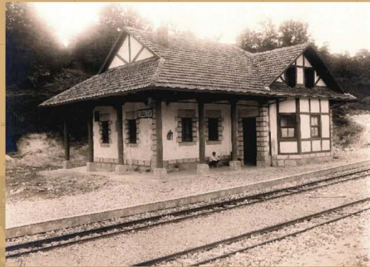
Estación de Laminoria
