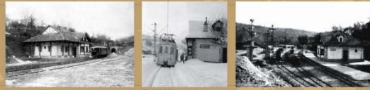
Apacadero de Laminoria y boca de entrada del túnel. (De la izquierda). Libro de Javier Aranguren sobre antemuros. Vista general de la estación de Laminoria. (M. E. de A. M. 1925-1927).
