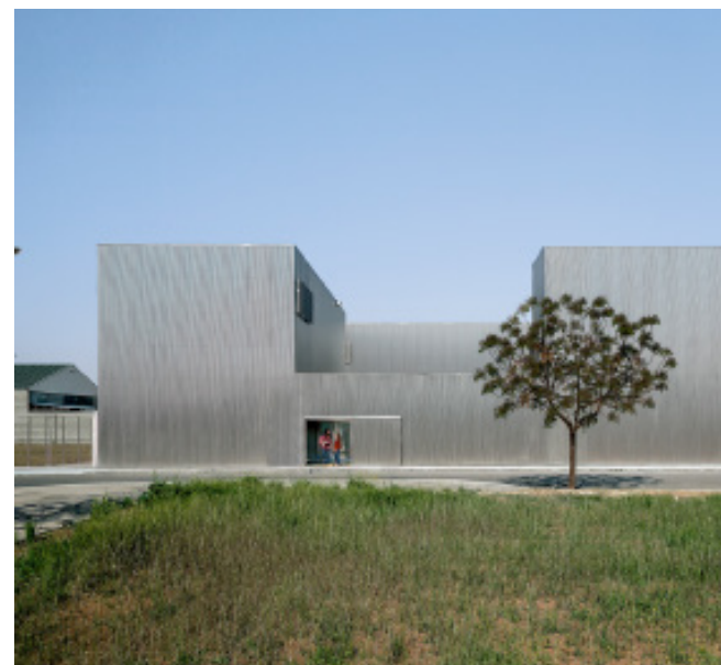
Proiektua: Industria de Montajes Eléctricos en Don Benito
