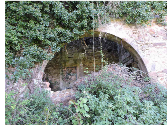
06 Estado actual del arco de \frac{1}{4} pto en la fachada NE, antigua entrada de caballos. Se mantiene la estructura y se cierra con un muro cortina
