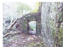
vista opuesta de muro eliminado
