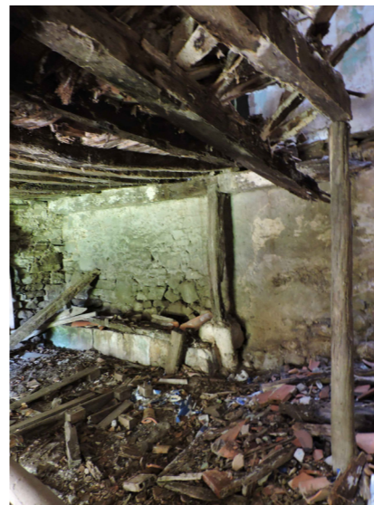
estado actual de la cuadra. Se retira la estructura de madera dejando el vacío un espacio vacío que comunicará ambos niveles (ascensor)
