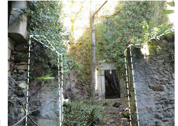
10 Eliminación de árboles y especies vegetales invasivas. Consolidación de muro e integración en el espacio expositivo (sala 2)
