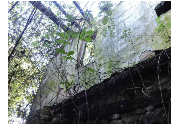
09 Muro de ladrillo añadido. Se retira y consolida el muro de mampostería sobre el que se apoya este.
