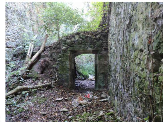
08 Se sustituye el muro de gran espesor por una escalera compensada logrando mantener la circulación traves de este paso.
