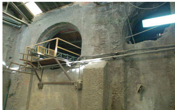
I.05.2 _Electra del Nervión barrutik. Nabeen arteko pasoa, kargahorma.
