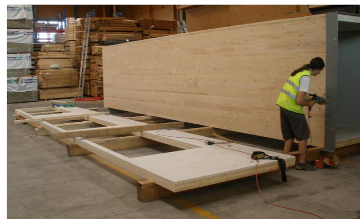
1. Panelen prestaketa eta igogailu kutxaren muntaketa.
