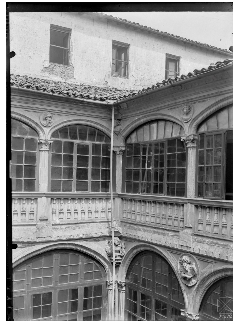
Claustro antes de la retirada de los cerramientos. Autor: Enrique Guinea. AM.
