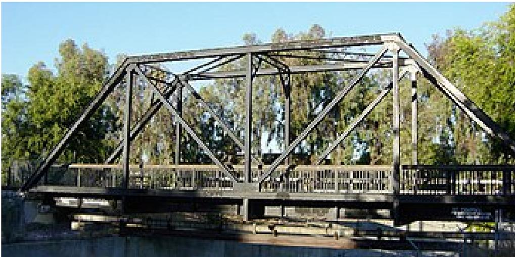
Foto 4. Puente de armadura
