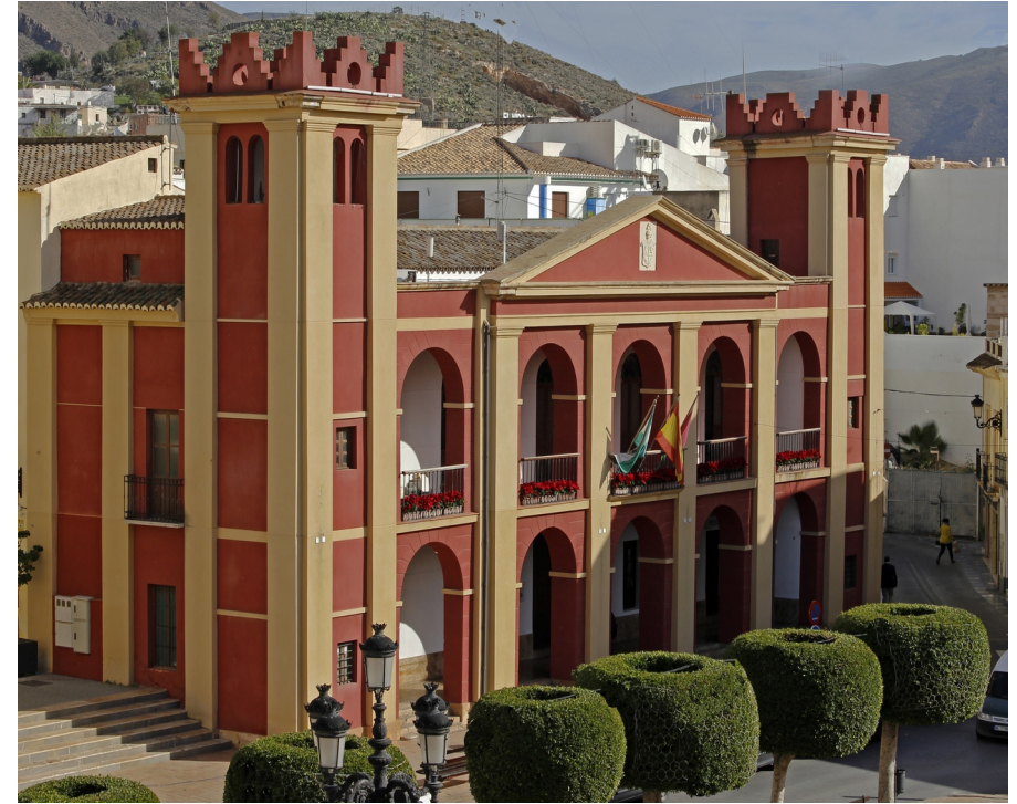
Fig. 7: Casa consistorial, Berja. Francisco Quintillán y Lois (sección central del edificio), 1787-1839. (Antonio Campos Reyes, Ayuntamiento de Berja)
