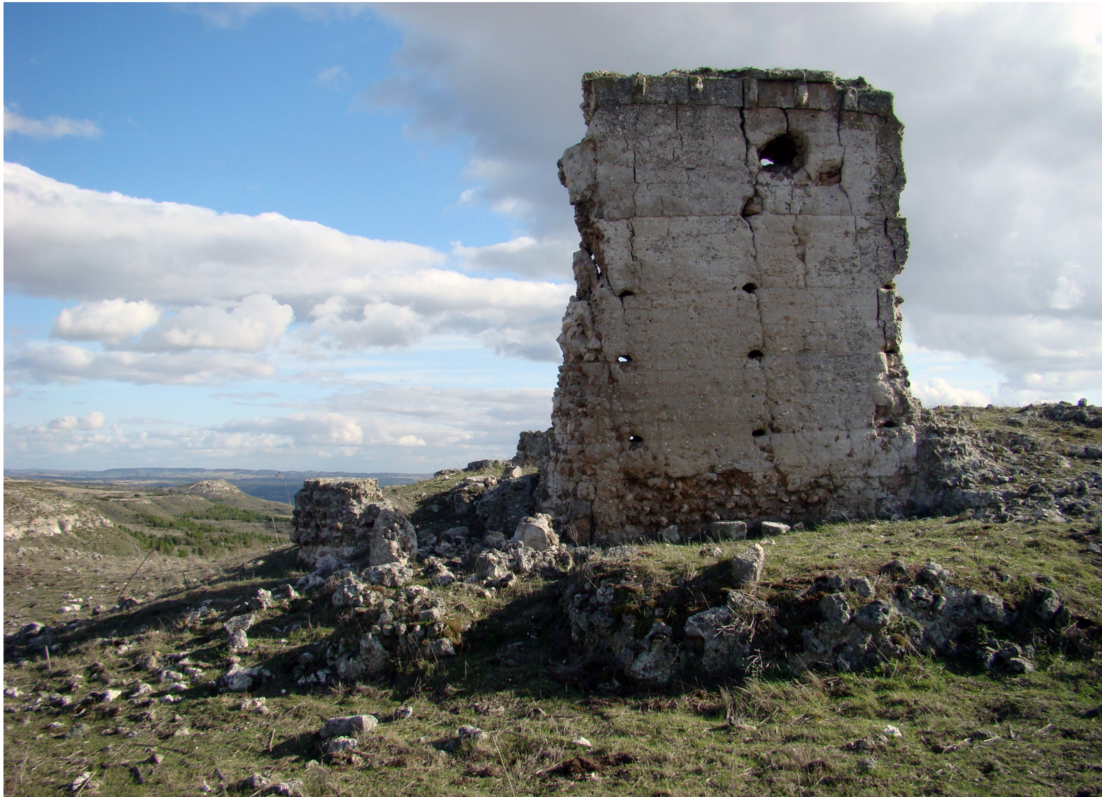
Fig. 7: Vestigios del ábside de la iglesia del despoblado de Hanos en Almoduera (Guadalajara)
