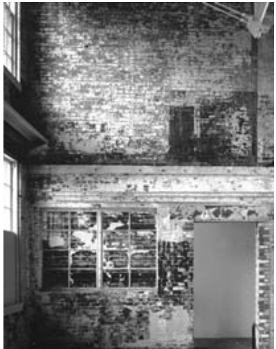
FIG. 8 Plasticidad de muchas paredes de ladrillo del viejo complejo industrial.
