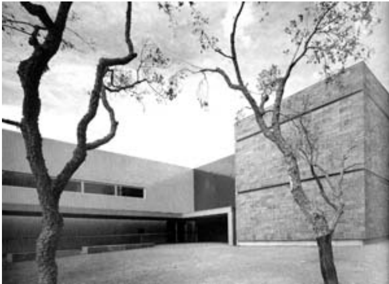
FIG. 10 Alcornoques del Alentejo que ofrecen su corcho como recubrimiento del Pabellón de Portugal.
