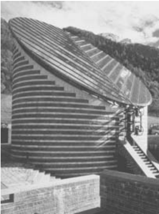
FIG. 1 Cilindro truncado en la iglesia de planta oval de San Juan Bautista donde el mármol blanco y el granito gris configuran una curiosa visión óptica que en el interior se amplia con sorprendentes efectos lumínicos.
