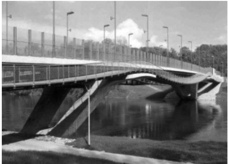
FIGURA 11 Puente Glacis. Ingolstadt sobre el Danubio, Schlaich. Un ejemplo formidable de la conjunción de sistemas estructurales «blandos» para resolver el paso.
