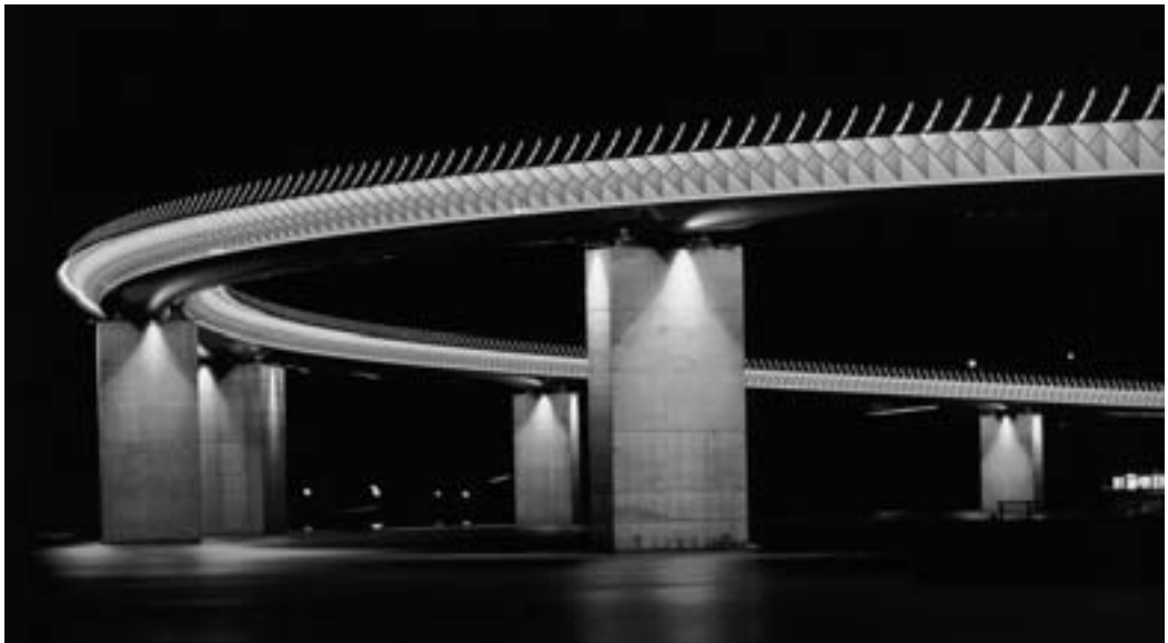
FIGURA 16 Puente Ushibuku-Kumamoto. Renzo Piano acentúa de una manera magnífica, justa y bellísima el borde de un dintel en sección cajón clásico.
