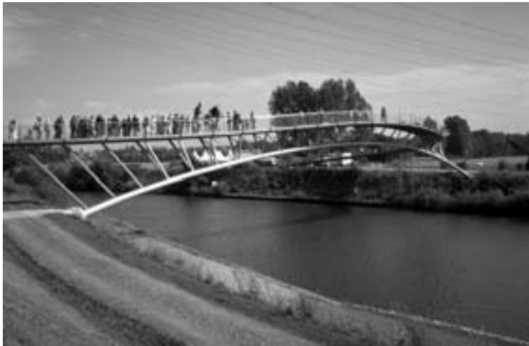
FIGURA 12 Pasarela de Ripshort, Schlaich. Una obra más que representa la destreza e imaginación de un formidable ingeniero.
