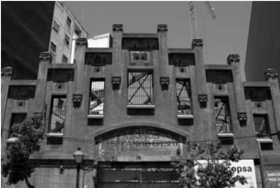
02. Almacén en la calle Maderas. Estado actual. Fondo CDR.
