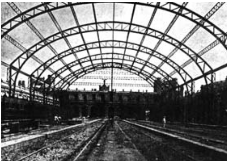
04. Construcción de la armadura metálica de la estación del Norte, 1916
