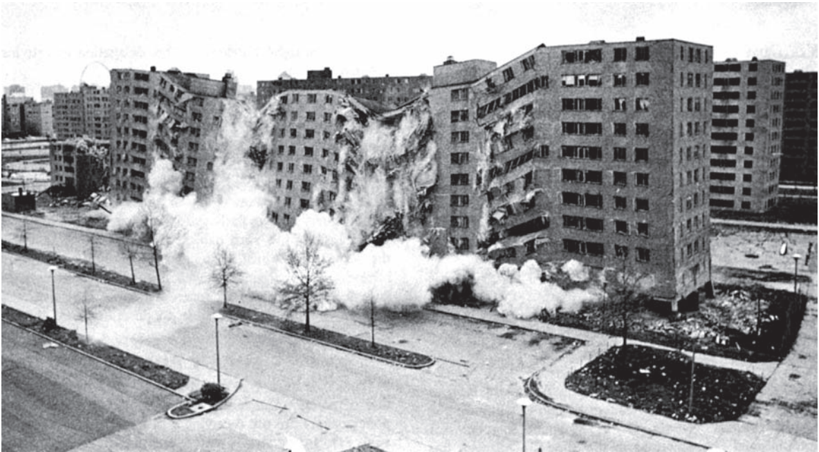
FIG. 7 El primer paso para la reconstrucción.
