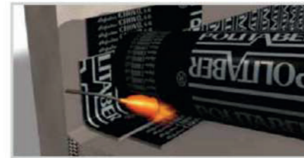
APLICACIÓN DE LA MEMBRANA.
