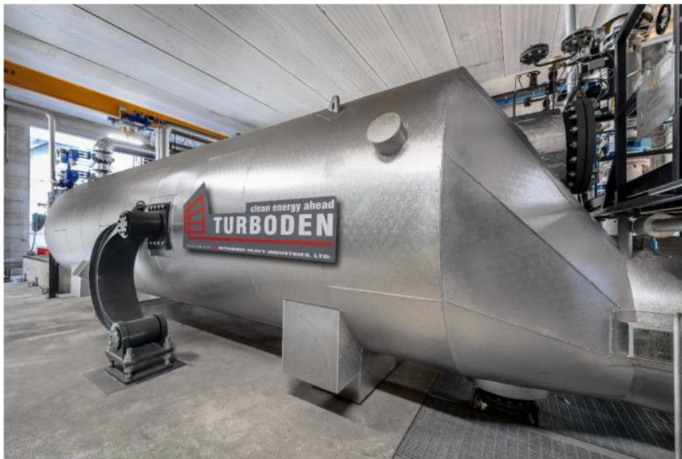
Ilustración 63. Turbina ORC para recuperación de calor en el HAE de ORI Martin, Brescia, Italia [TURBODEN]
