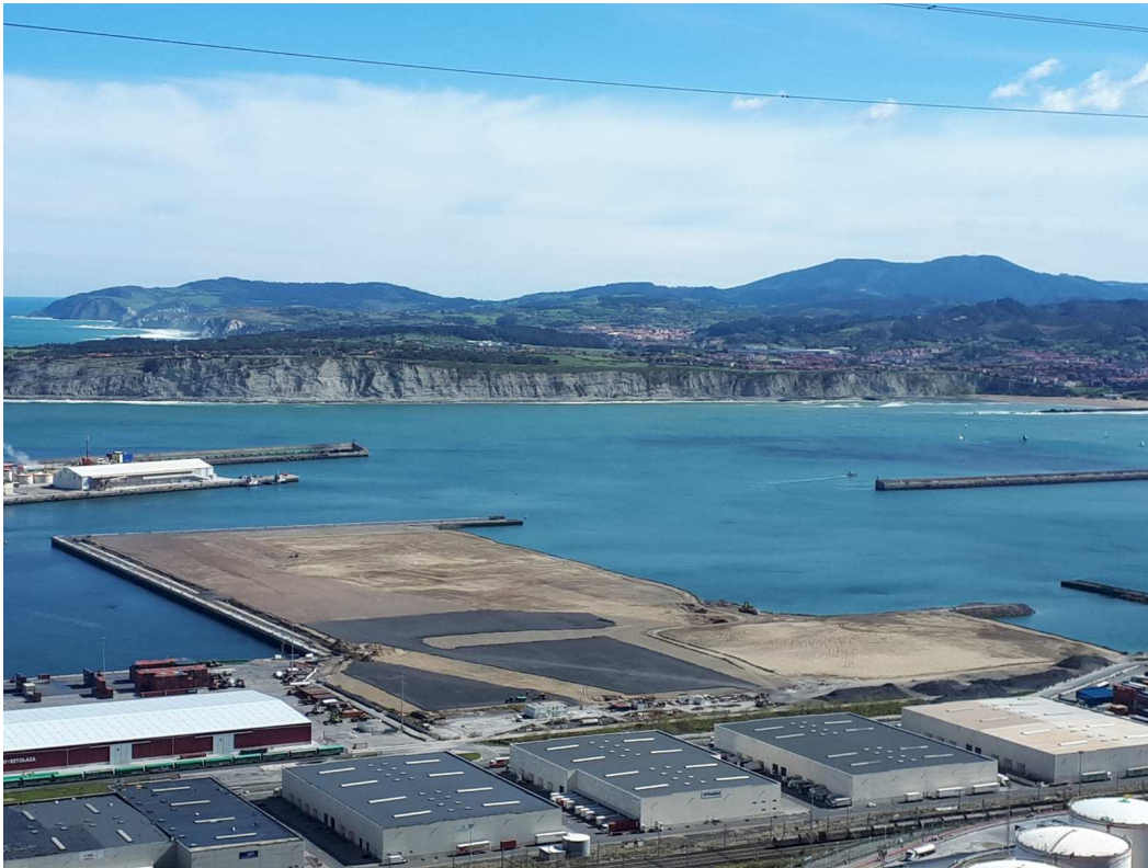
Ilustración 43. Explanada mejorada del espigón central en el Puerto de Bilbao [APB]
