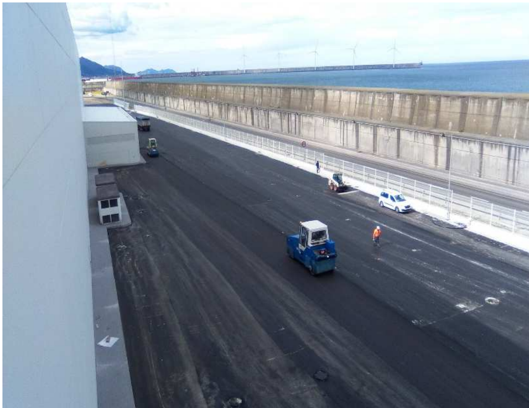
Ilustración 42. Compactado de la pavimentación en la explanada de muelle Punta Sollana en el Puerto de Bilbao [APB]
