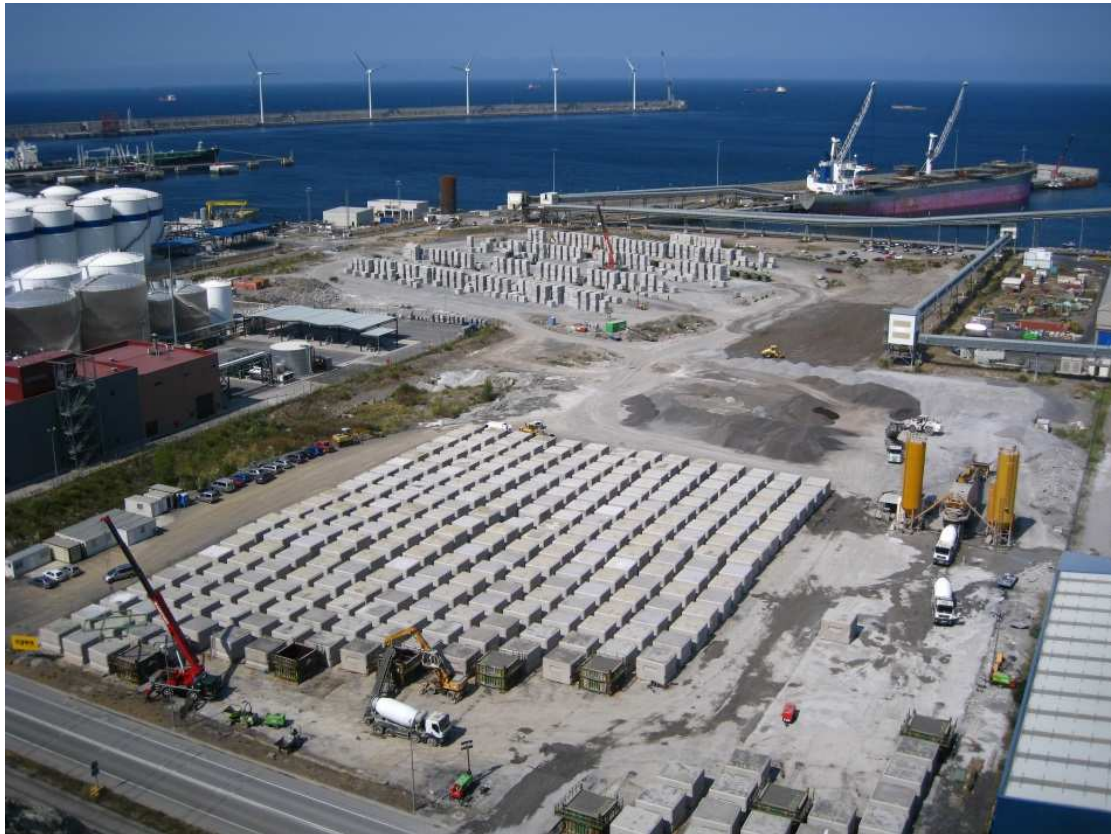
Ilustración 41. Acopio de bloques de reposición en la explanada de Punta Sollana [APB]
