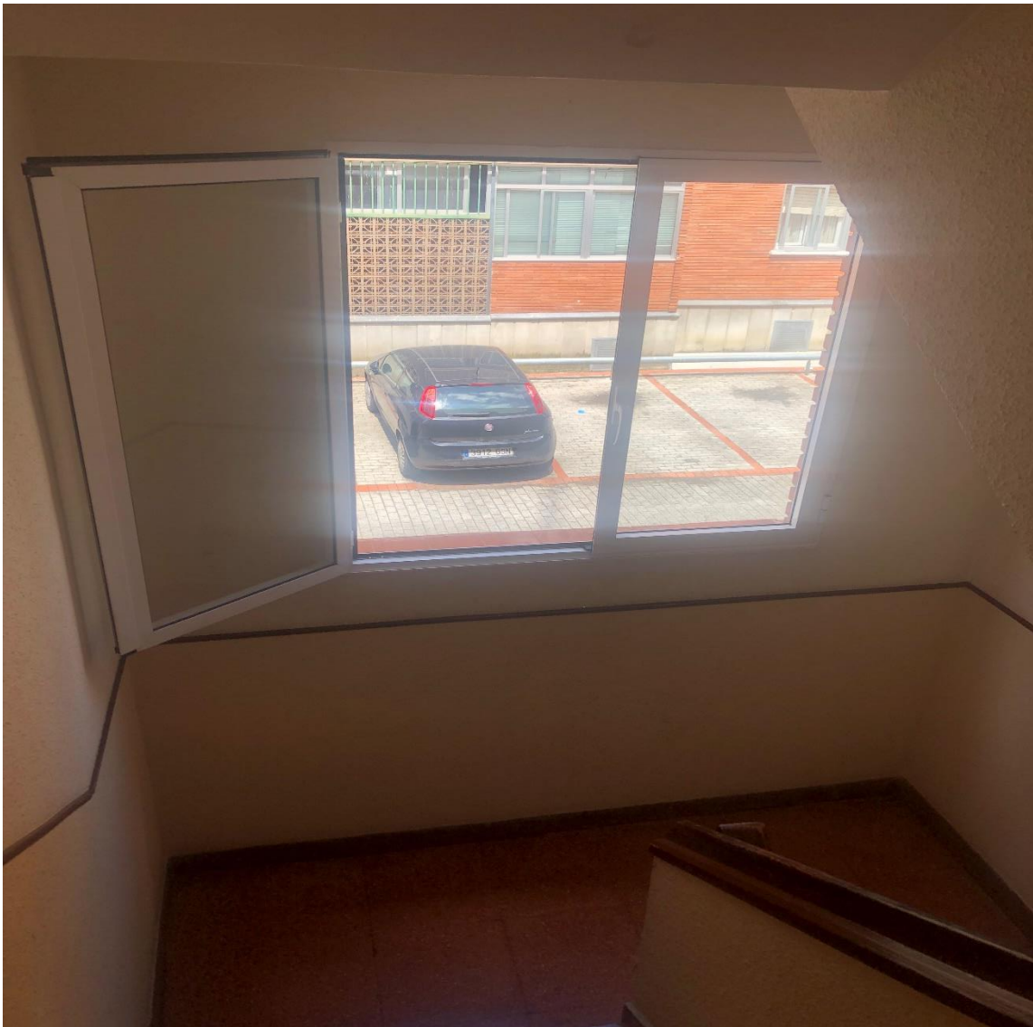
Ilustración 4. Descansillo de escalera con quiebro.
