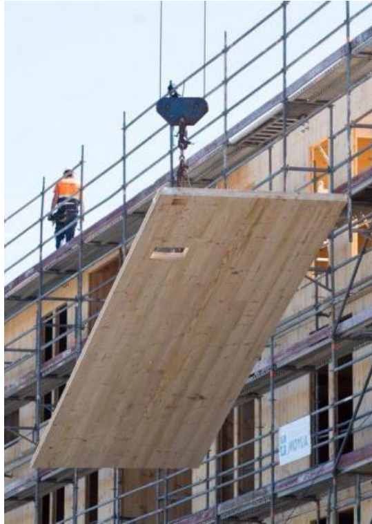
Ilustración 13. Panel CLT colocado en obra. Fuente: Egoín.
