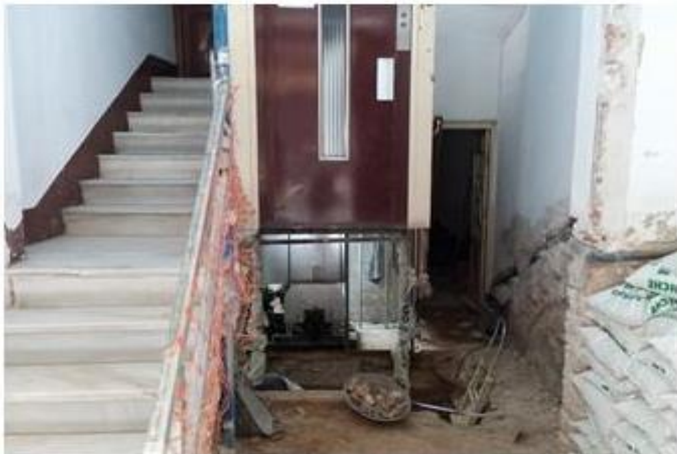
Ilustración 9. Obras de bajar para cota a cero. Fuente: bt2asociados.
