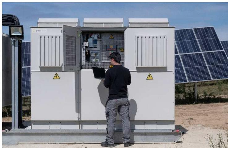
*Figura 5.* Inversores trifásicos IFX6 de Jema Energy.
