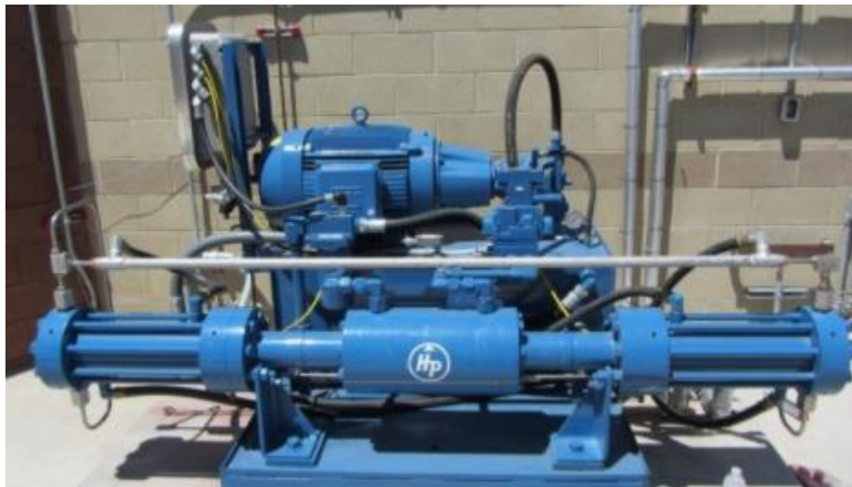
Ilustración 52 Compresor de alta presión. [Hydropac Compressors, Inc. 2019]
