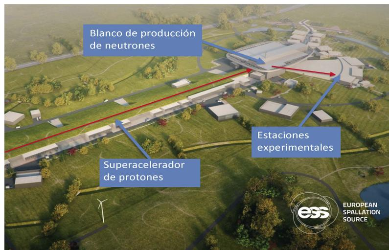
**Figura 1.1:** Esquema de la Fuente Europea de Neutrones por Espalación (ESS) en Lund, Suecia. Figura extraída de [6].
