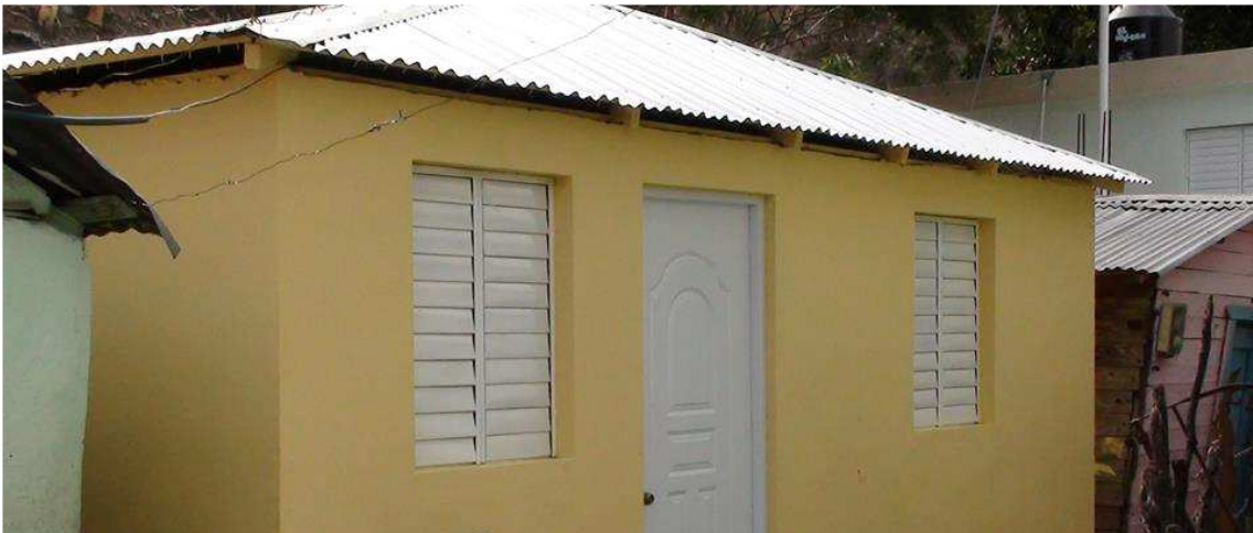
Figura 8. Vivienda con muros de bloques de hormigón vibrado enlucido con mortero y techo de zinc.
