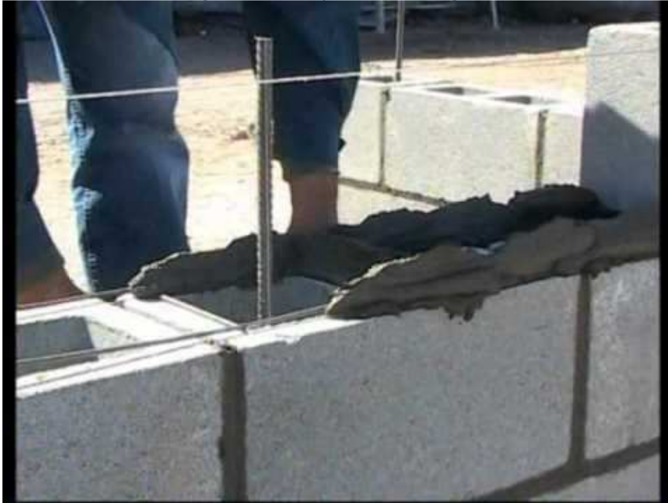
Figura 11. Muro de bloques de hormigón con revoque de mortero.
