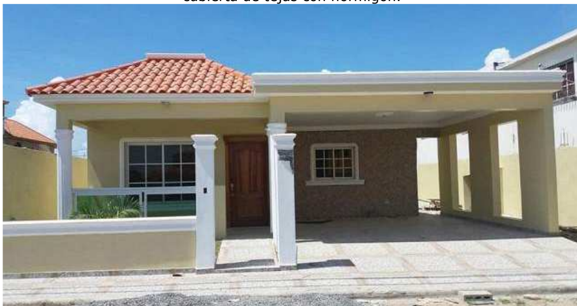
Figura 9. Vivienda con muros de bloques de hormigón vibrado enlucido con mortero y cubierta de tejas con hormigón.
