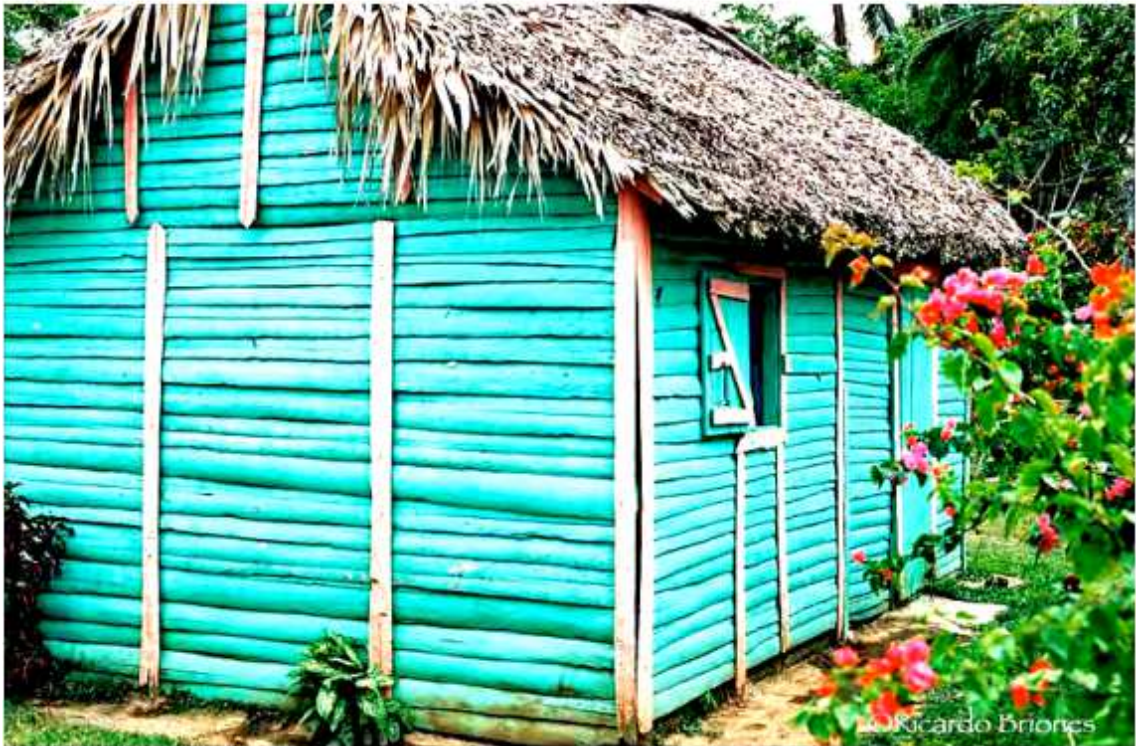
Figura 6. Vivienda con muros de madera y techo en cana. Fuente: Ricardo Briones.
