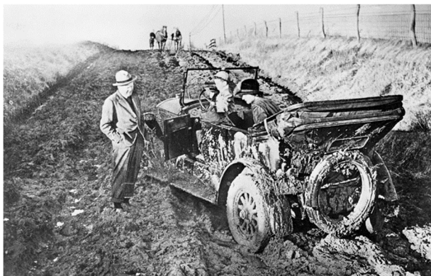
Figura 180. Carretera en el condado de Johnston (Carolina del Norte), 1909.
