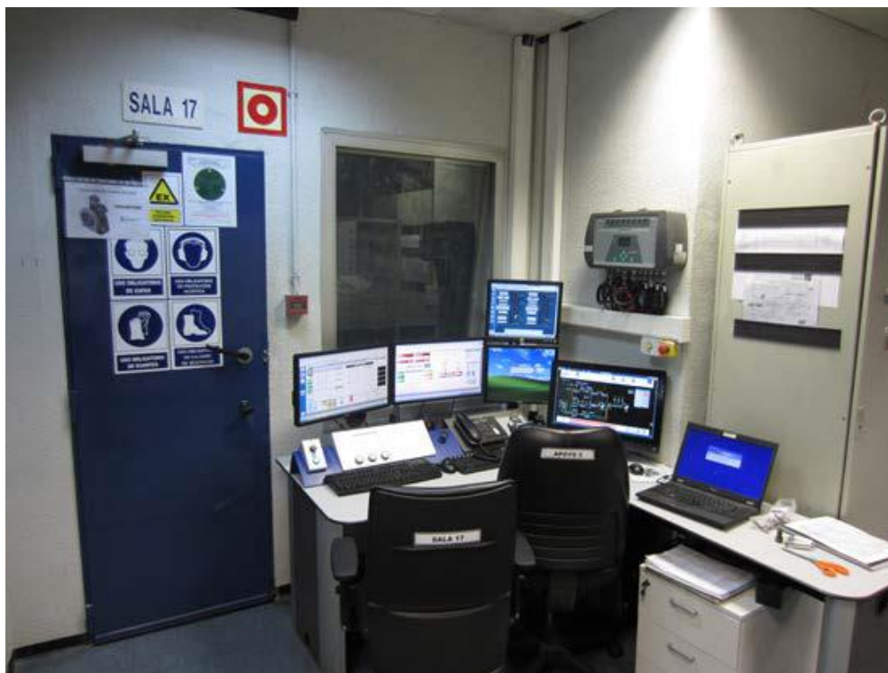
Figura 60. Puesto de control del banco de ensayo SCE.
