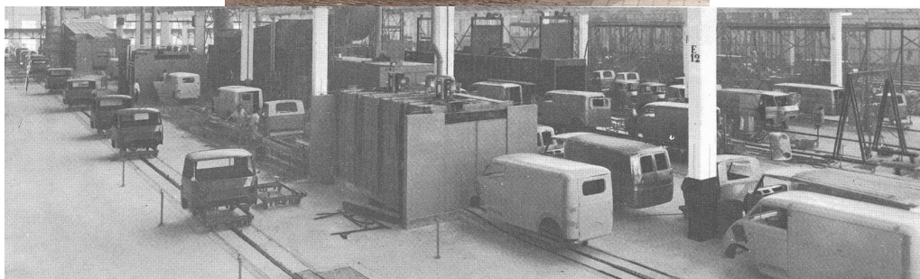
Irudia 1 DKW F89L eredua, bere azpian Gasteizko lantegiaren fabrikazio prozesua.
