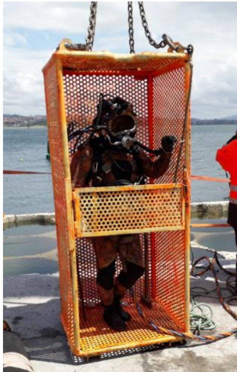
Figura 3.6: Submarinista en la jaula preparado para bajar a la celda [4]
