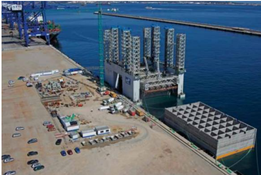
Figura 2.3: Construcción de cajón en dique flotante [2]
