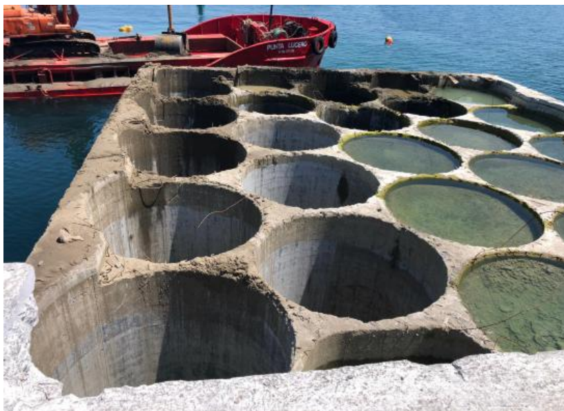
Figura 3.4: Extracción de material de las celdas [4]
