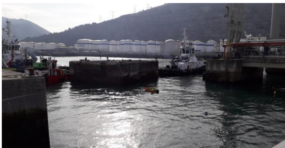
Figura 6.6: El cajón, momentos antes de llegar a su posición final [4]
