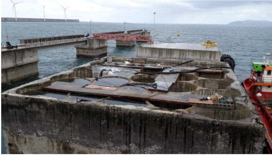
Figura 6.7: Cajón fondeado en su posición final [4]
