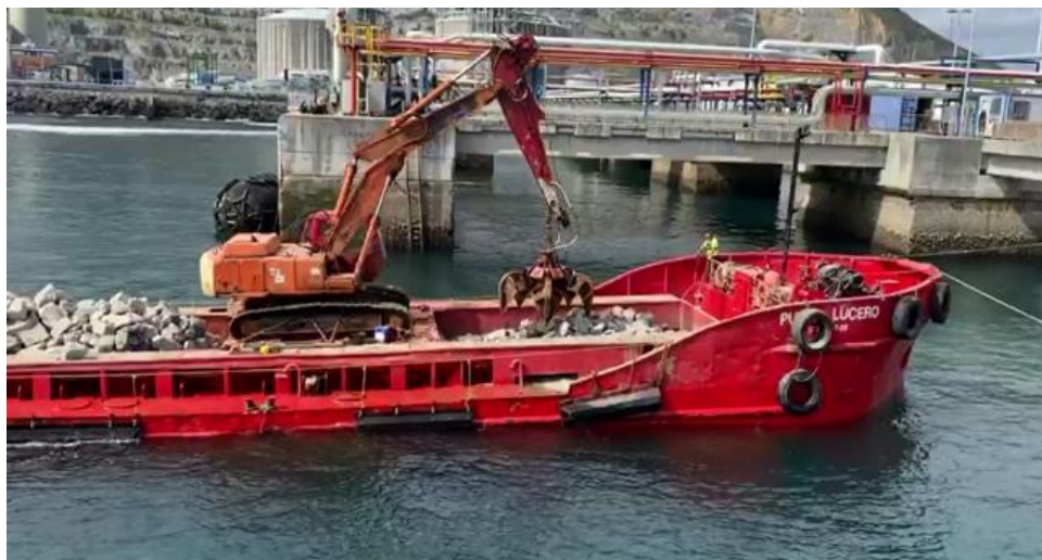
Figura 6.5: Gánguil vertiendo el material para preparar la base del cajón [4]
