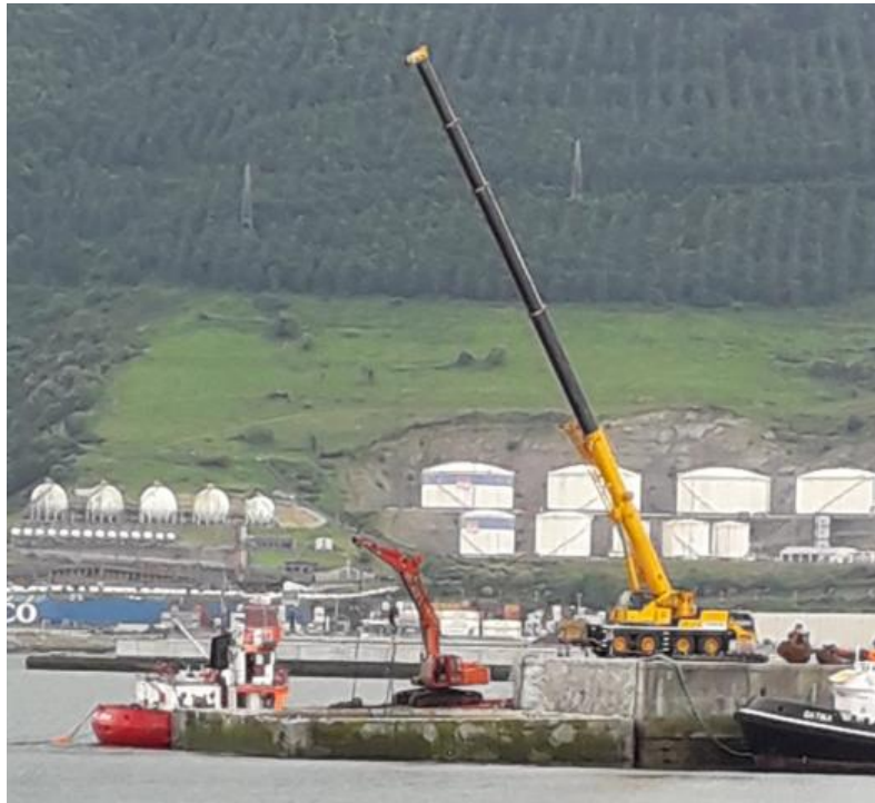
Figura 3.5: Grúa desde tierra para extracción de material [12]
