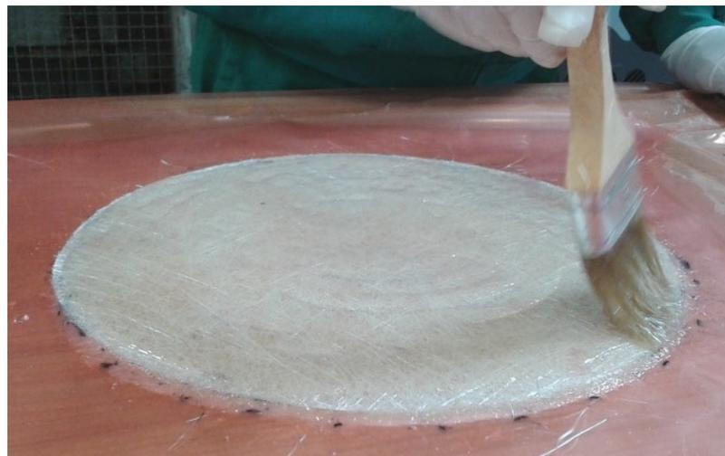
Figura 3.5. Preparación del laminado por impregnación manual de la fibra
