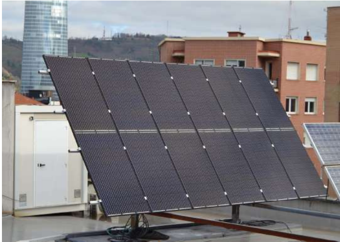
Figura 4.2. Sistema FV de 3,42 kW formado por 12 módulos FV Jinko JKMS285M-60.
