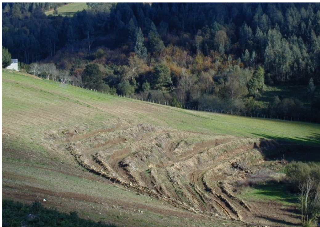
Figura 25. Aterrazamiento de una ladera con medios mecánicos en el margen derecho del río Eume (A Coruña). Fotografía: Paula Ballesteros-Arias.
