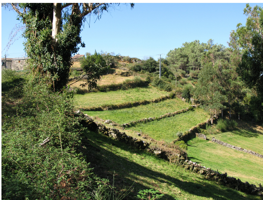
Figura 26. Terrazas en Airoa (Fornelos de Montes, Pontevedra) con muros y cierres en piedra seca. Entre ellas hay un sistema de canales y surcos que permiten tanto el regadío como el drenaje de las aguas superficiales. Fotografía : Incipit CSIC.
