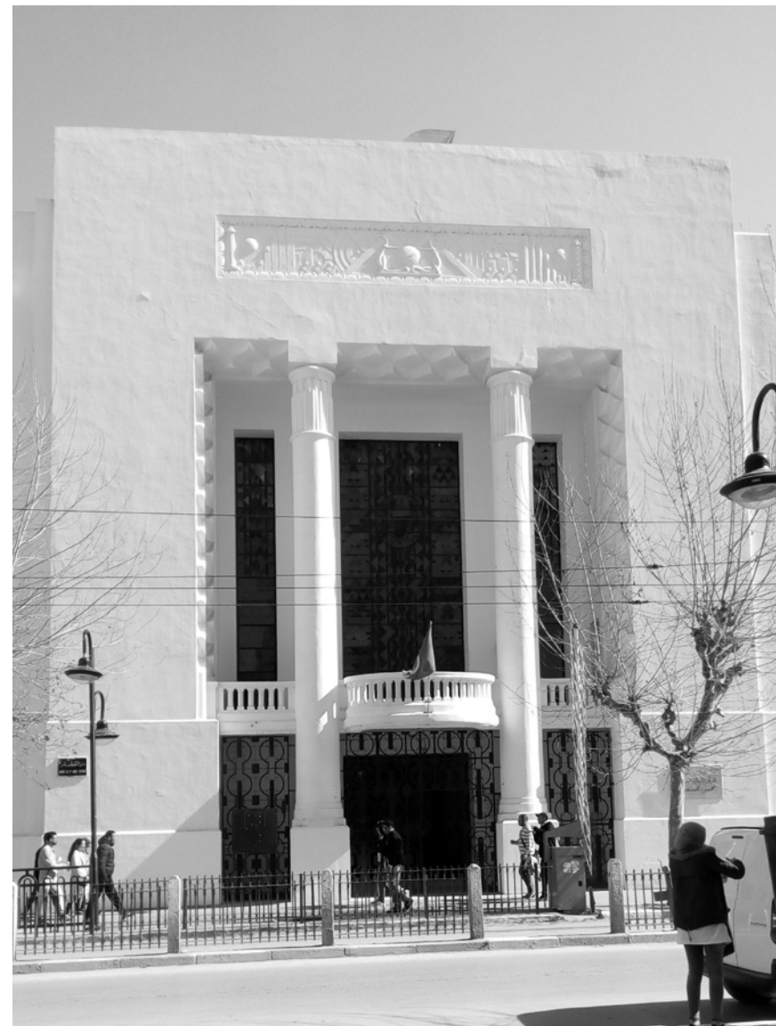
Fig. 8: Puerta de acceso a la sala de actos del Lycée Carnot. Hiriart y Seignouret, 1935
