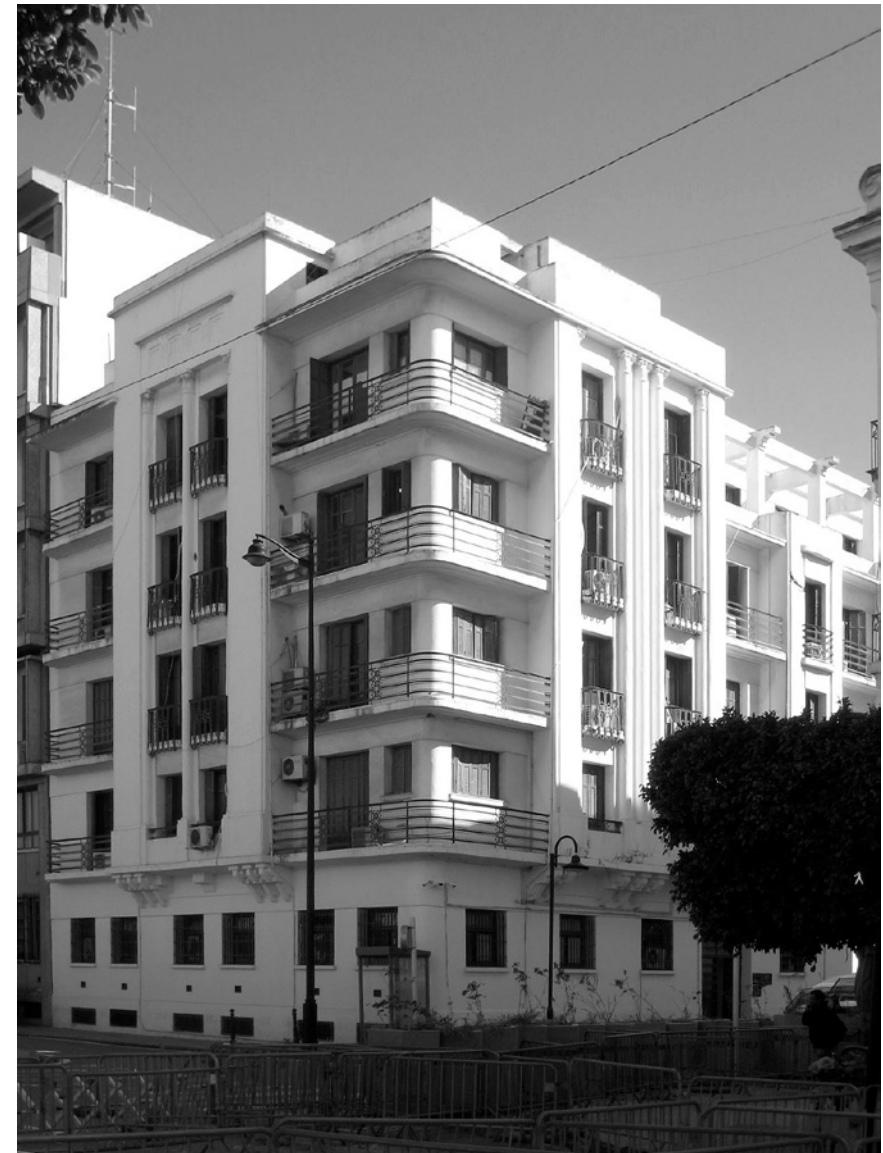
Fig. 5: Inmueble de la avenida Jules Ferry. Hiriart y Seignouret, 1930
