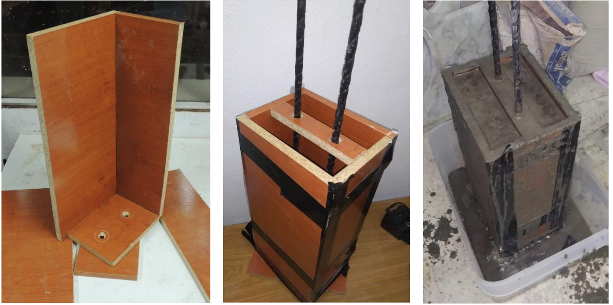
Figura 82. Proceso de realización del poste del remate rectangular. 2020.
