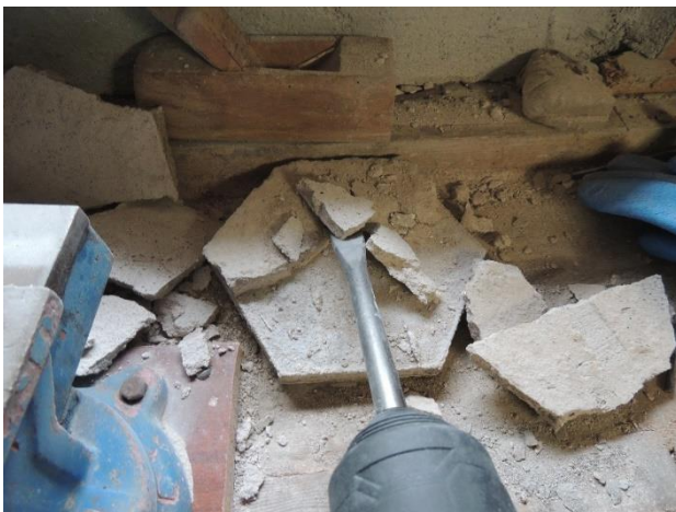
Figura 109. Eliminación de morteros con la ayuda de un taladro percutor. 2021.
