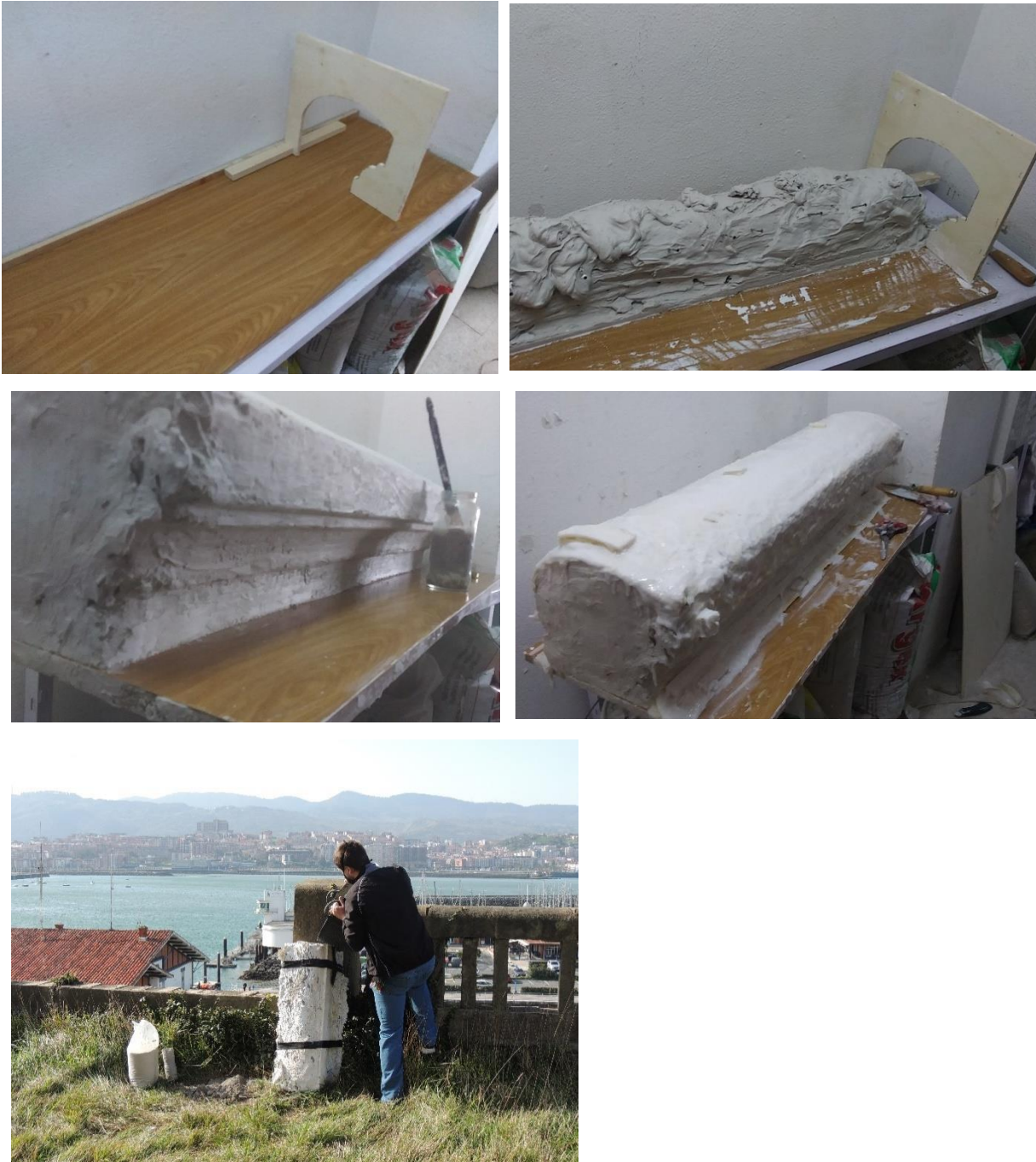
Figura 83. Proceso de realización del barandal superior
