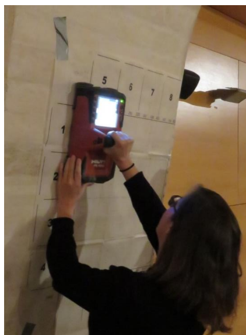
Figura 39. Radar para el estudio de armaduras en el hormigón armado. Demostración realizada en las XIII Jornadas de Conservación y Restauración – Materiales y técnicas innovadores para la conservación y restauración del hormigón: Innova Concrete. 2019.
