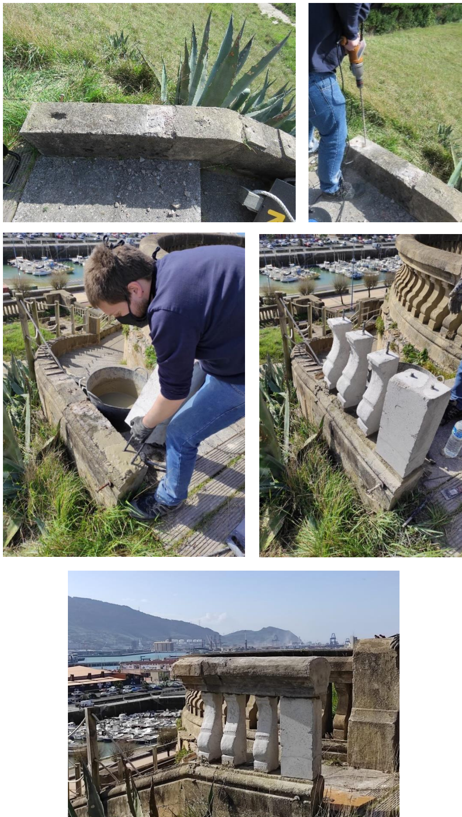
Figura 84. Ensayo de recolocación de las piezas.
