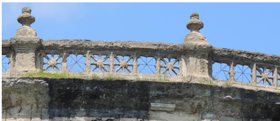
Figura 33. Torreón de Zarautz y detalles de sus balaustradas
