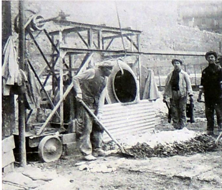
Figura 15. Ejemplo amasado con una hormigonera. Extraída de Extraídos de Lefol (1906) Colección Particular.
