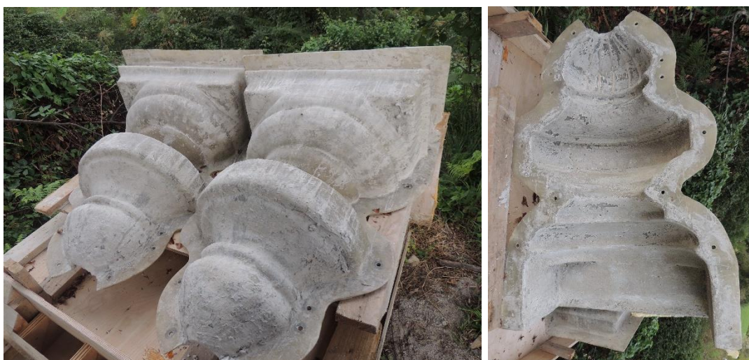
Figura 74. Moldes rígidos utilizados para la reproducción de elementos en la intervención realizada en el Torreón de Zarautz (2019).
