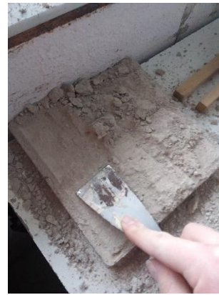
Figura 108. Proceso de eliminación de mortero con medios manuales. 2020.
