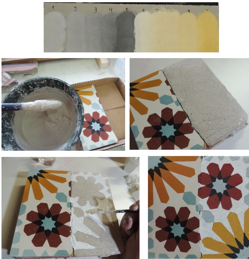
Figura 112. Proceso de reintegración volumétrica y cromática con morteros de cemento y pintura al silicato. 2021.
