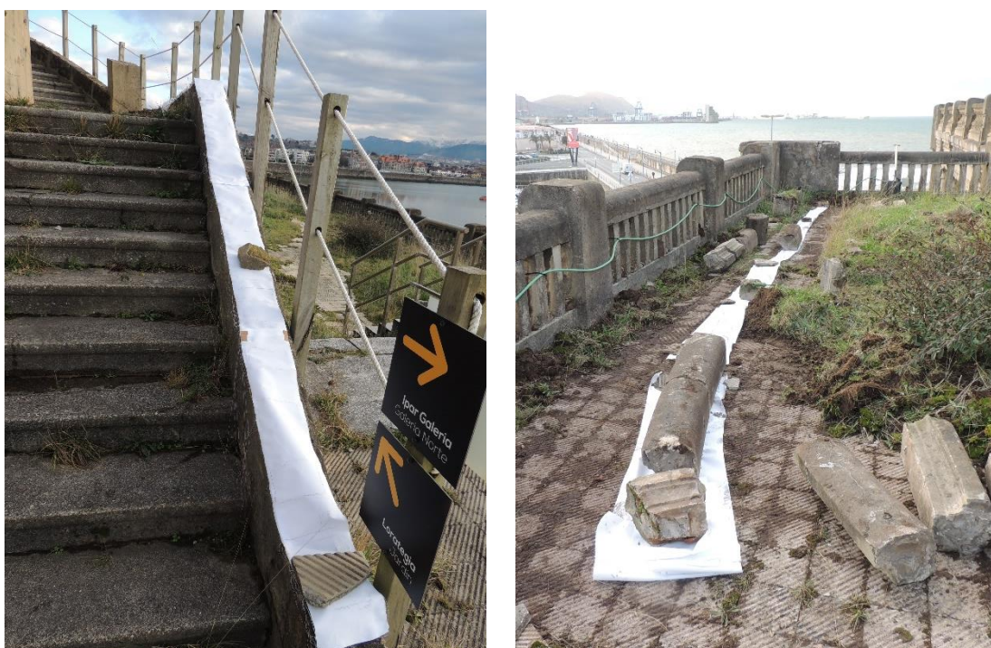
Figura 68. Imágenes del proceso de clasificación de los elementos del modelo B con la ayuda de un frotaje .2019-2021.
