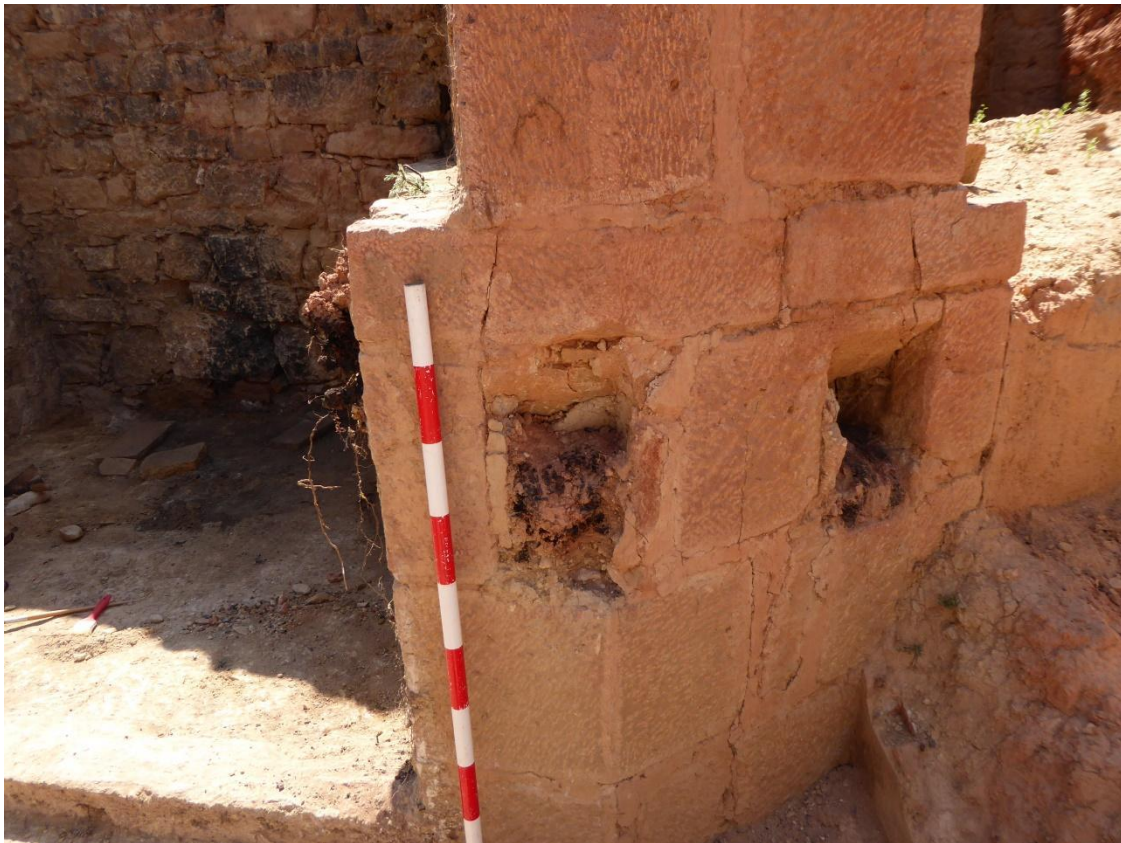
Figura 172. Muestra de dos mechinales del contramuro UE 2063. Puede verse cómo después de ser colocada la viga con una orientación de 45°, gracias a la inclinación de la parte superior interna del mechinal, quedaban selladas en el lugar mediante argamasa
