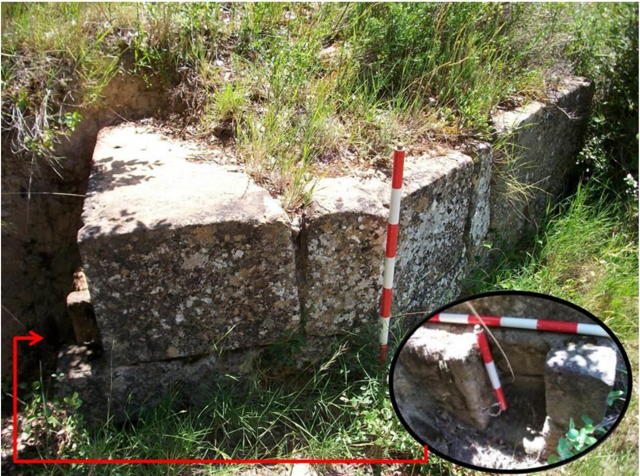
Figura 111. El conjunto de piedras de sillería, con un mechinal en la margen izquierda
