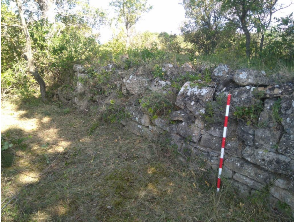
Figura 112. Tramo del muro norte
