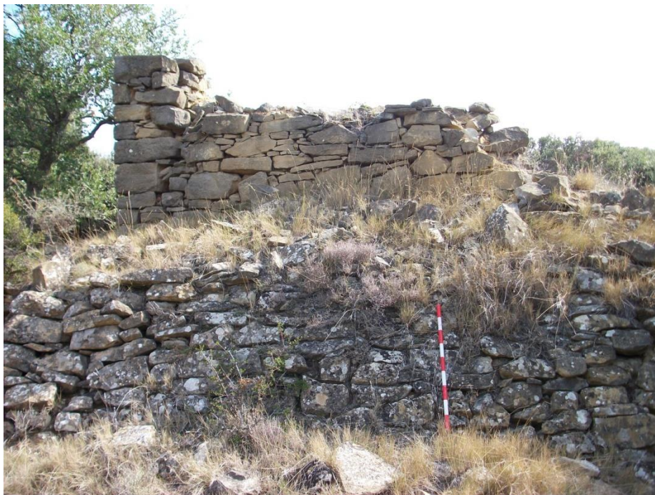
Figura 23. Contramuro sobre el ala este del edificio, visto desde la luneta
