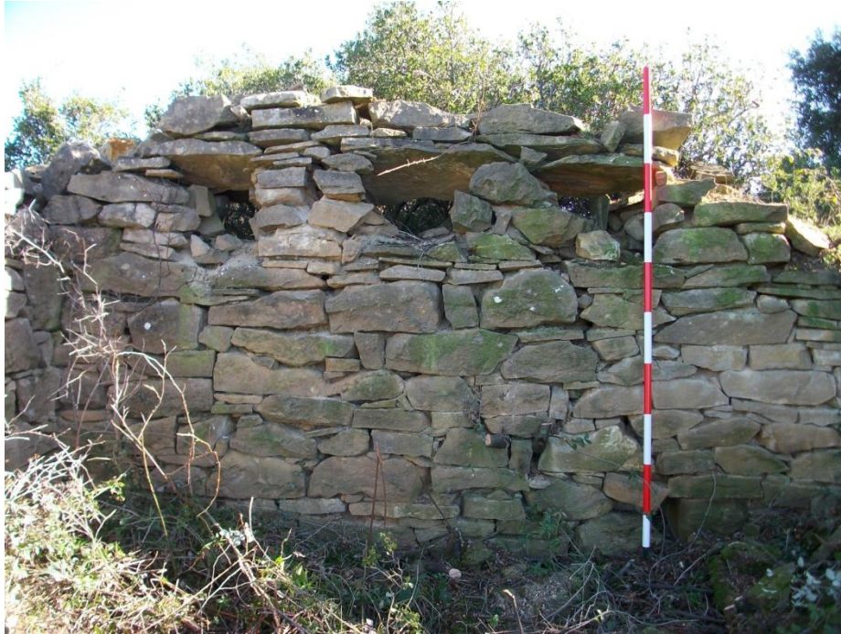
Figura 22. Muestra de tres aspilleras desde el interior del fondo del ala este del fuerte. Se ve cómo a 1,20 m de altura se inicia la estructura de la aspillera
