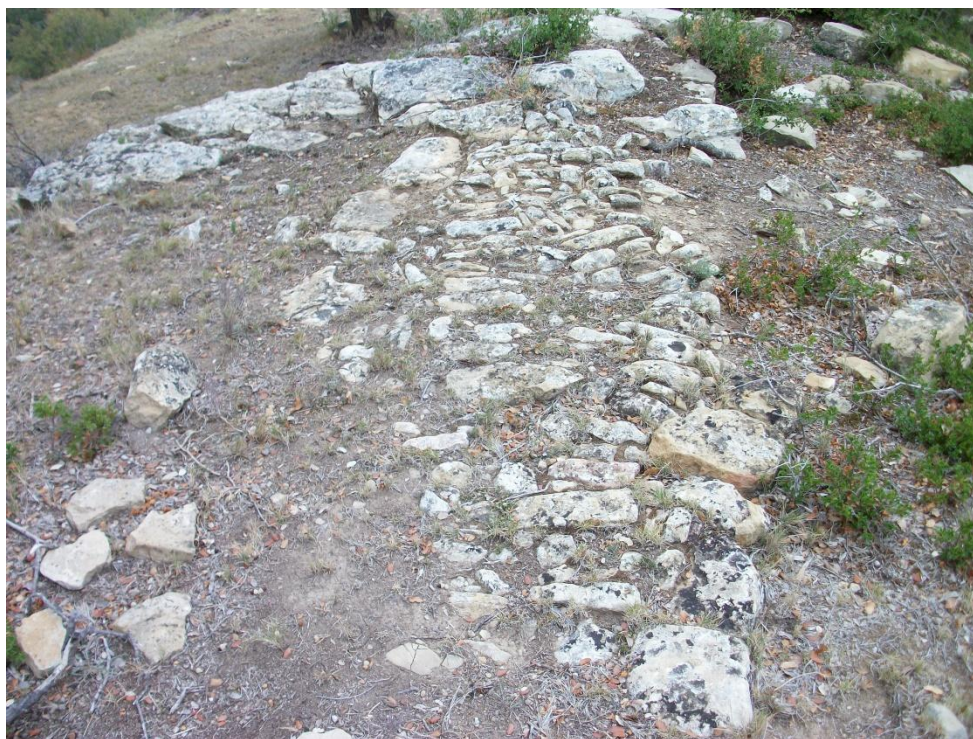
Figura 165. Imagen del tramo de camino empedrado que se conserva. Tiene una orientación suroeste - noreste
