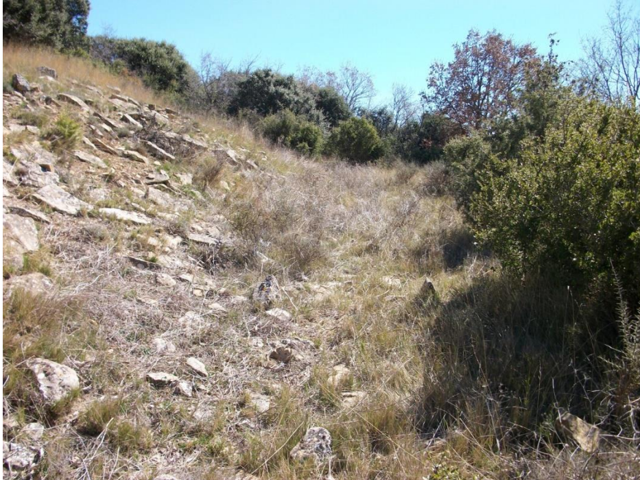
Figura 24. A mano izquierda la escarpa de la luneta, con los desprendimientos de piedra de su parapeto interior. A mano derecha, la huella de lo que fue el foso, hoy totalmente colmatado
