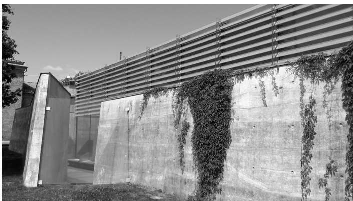
Fig.34: Imagen de la Ampliación del Museo Nacional de Arquitectura de Oslo diseñado y construido por Sverre Fehn entre los años 2003 y 2008. Primavera de 2016.
