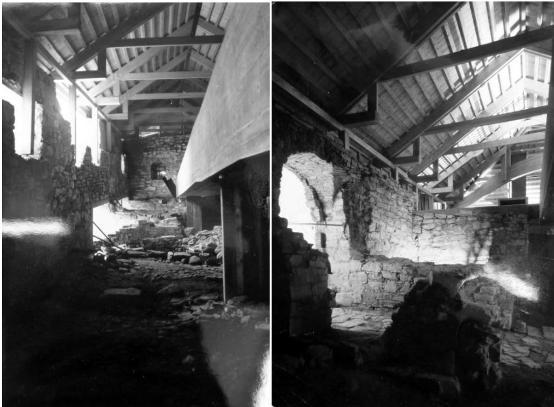
Figs.158 y 159: Imágenes del ala oeste, donde mejor se aprecia la relación de las ruinas medievales con la nueva arquitectura. El hecho de situar una pasarela sobrelevada permite ver los restos desde una perspectiva cambiante, una manera de las maneras que Fehn tenía de poner en valor lo antiguo. Nasjonalmuseet Arkitektur.
