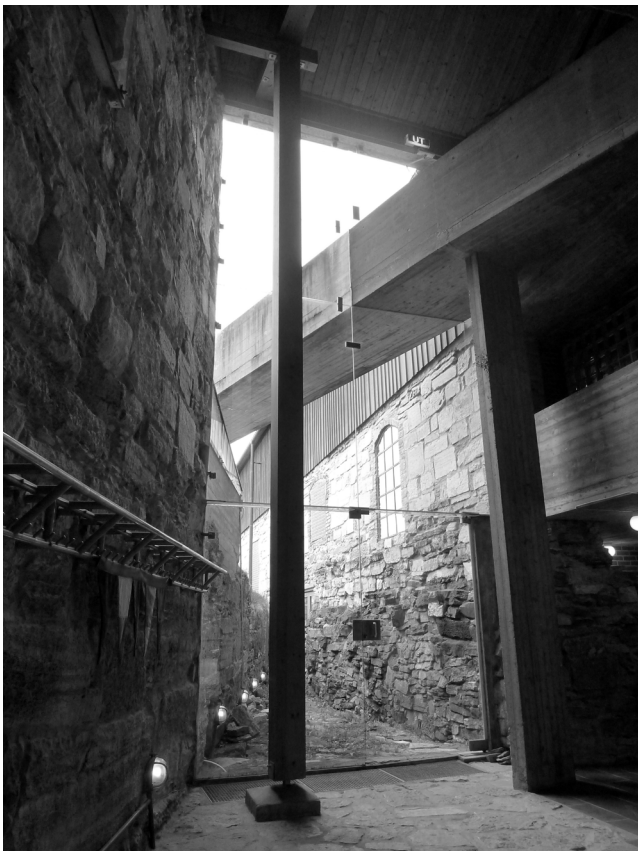
Fig.6: Disposición de los paneles de vidrio transparente en su encuentro con los muros existentes y la rampa de hormigón armado, que atraviesa el vacío del paño vertical. Primavera de 2016.
