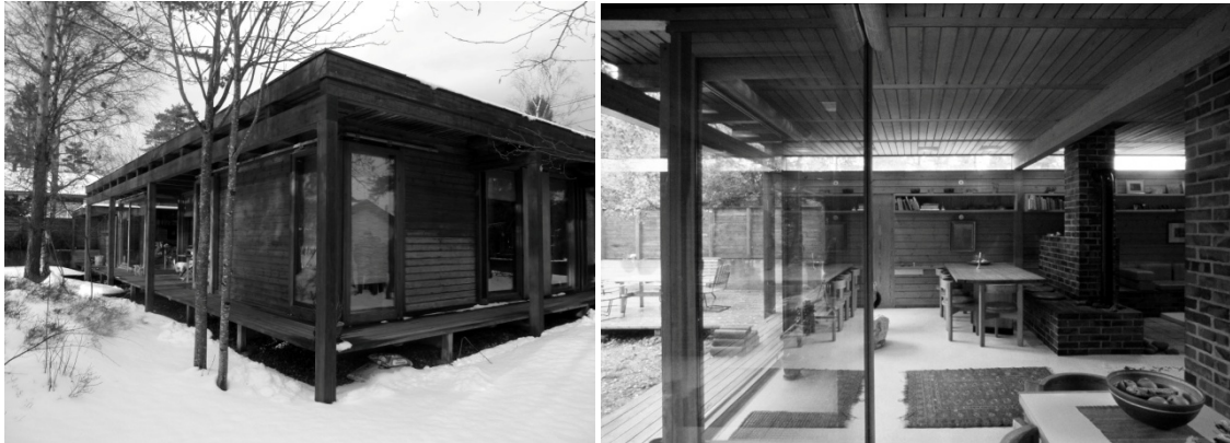
Fig.150: Imagen del jardín exterior de la Villa Schreiner. Se aprecia que la villa se suspende unos pocos centímetros sobre el terreno y dispone de una galería cubierta perimetral, rasgos típicos de la arquitectura tradicional japonesa. Invierno de 2015.
