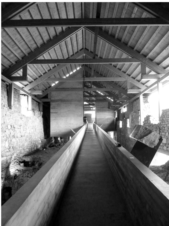
Figs.199 y 200: Imágenes de dos de las rampas de hormigón armado de 1,15 metros de anchura. A la izquierda, la rampa de la crujía central del museo. A la derecha, la rampa helicoidal exterior situada en el patio. Primavera de 2016.
