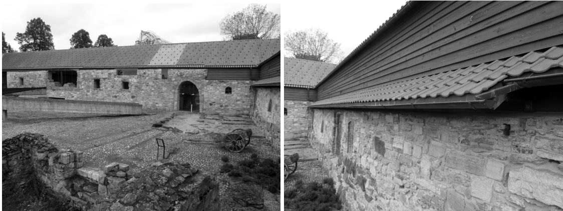
Fig.37: Vista del patio del Museo Hedmark donde se observa el portón trasero y la rampa helicoidal que asciende hasta la planta superior. Asimismo, en la parte derecha, se aprecia el comienzo de la tejavana sobre el muro de piedra de la antigua fortaleza del obispo. Primavera de 2016.
