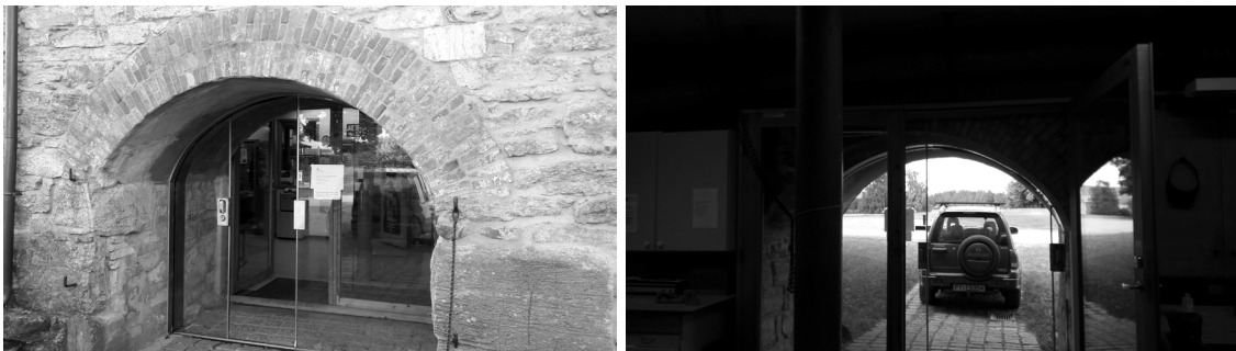
Figs.216 y 217: Imágenes del umbral de acceso a la magazine. A la izquierda, imagen tomada desde el exterior con la puerta corredera de vidrio en primer plano. A la derecha, imagen tomada desde el oscuro interior al que se accede, con la gruesa carpintería de madera. Primavera de 2016.
