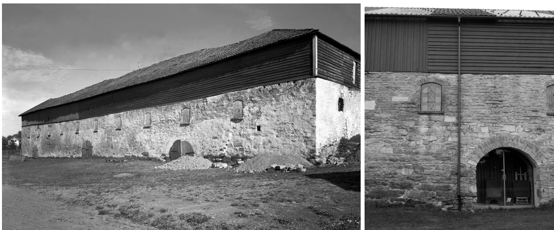
Figs.142 y 143: Imagen de mayo del año 1947. Fachada norte del ala norte del granero. De entre las tres puertas que existen en la planta inferior, a la altura de la puerta central, se aprecia que se produce un cambio de trazado en las líneas del entablado de madera. Esta alteración de líneas verticales a líneas horizontales es respetada por Fehn en su intervención sobre el patrimonio construido. Esto se observa en la Vista de la derecha, tomada en la primavera de 2016. Nasjonalnuseet Arkitektur Fotoarkiv.
