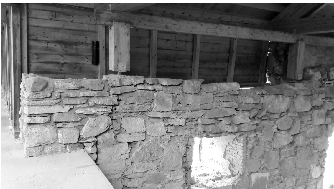
Fig.11: Vista de los muros de piedra existentes coronados y atados por un cordón perimetral de hormigón armado que aporta estabilidad y cohesión al estrato antiguo. Primavera de 2016.
