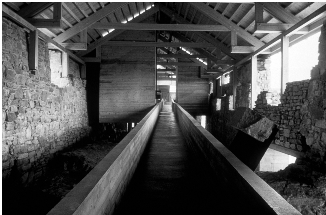
Fig.130: Vista interior del ala oeste del Museo Hedmark. Crujía en la que se exponen los objetos de la Edad Media, los más antiguos del lugar. La rampa contemporánea de hormigón armado sobrevuela las ruinas medievales incidiendo en dos únicos puntos. Los nuevos materiales no se ponen en contactos con los viejos muros de carga. Nasjonalmuseumet Arkitektur Fotoarkiv.
