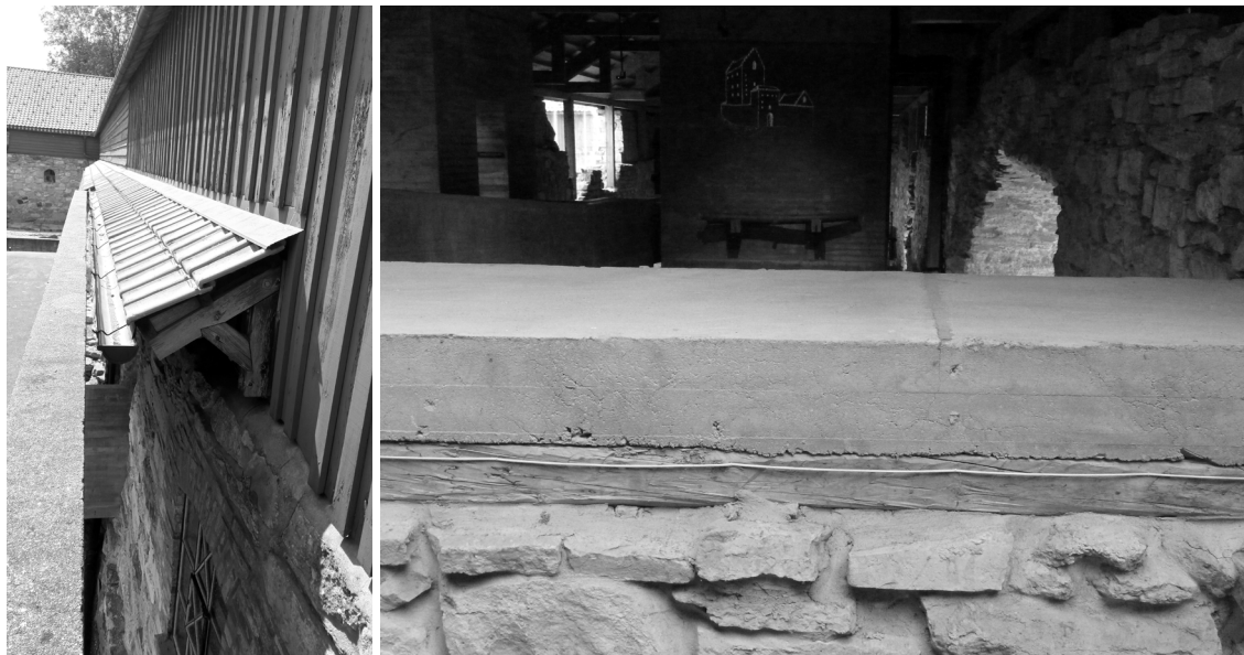
Fig.128: Imagen de la tejavana exterior que se construyó posteriormente, en el año 1979, para la protección de la parte superior del muro de piedra de la antigua fortaleza del obispo. Primavera de 2016.
