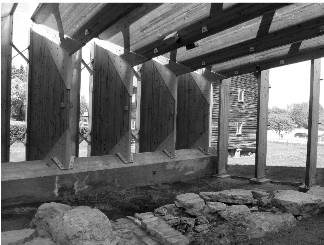
Fig.93: Vista interior de una de las esquinas del nuevo pabellón. Se aprecia la protección solar en la orientación oeste, donde la luz no consigue penetrar directamente hasta las ruinas. También se observa la tensión entre el plano del suelo y el plano de cubierta. Primavera de 2016.
