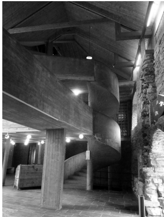
Figs.105 y 106: Imágenes del espacio triangular a triple altura con las rampas de hormigón sobrevolando el espacio y cruzándose entre sí a diferentes niveles. La rampa superior incluso sale del edificio hacia el patio. Es interesante el contraste entre verticalidad y horizontalidad marcado por la escalera helicoidal y el poste de madera que sostiene la cubierta, frente a las rampas de hormigón armado. Primavera de 2016.
