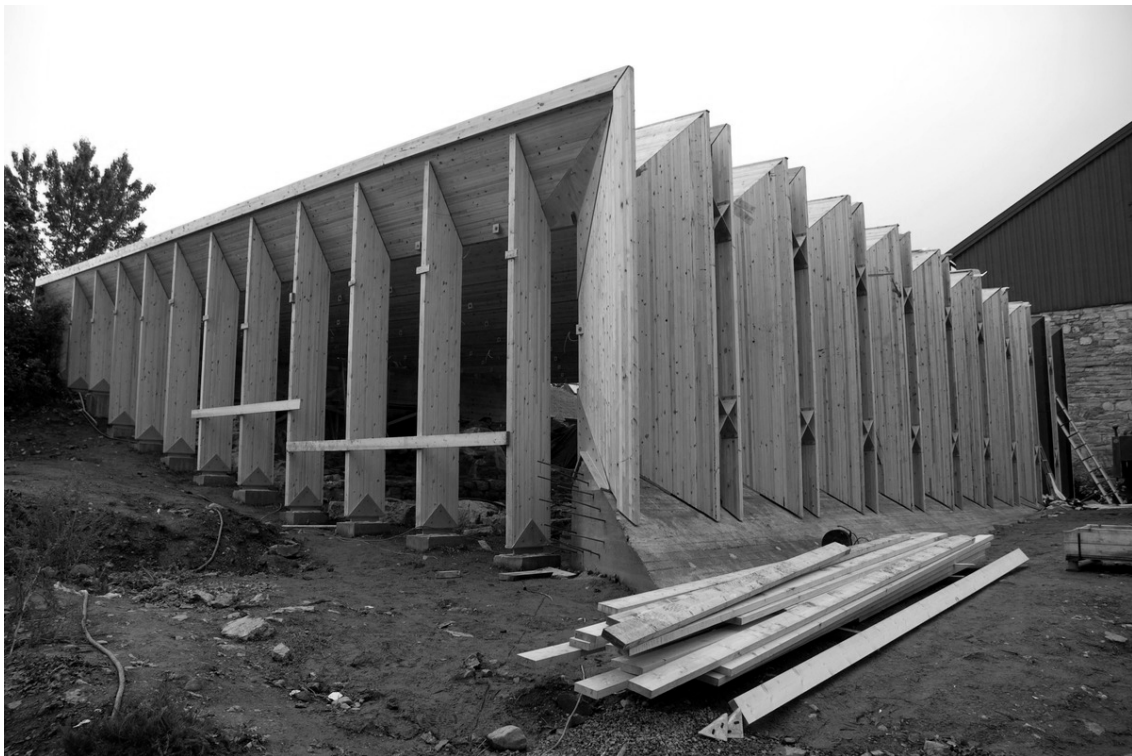
Fig.91: Vista del proceso de obra de la ampliación del Museo Hedmark. La importancia del encuentro entre la estructura y el terreno. Imagen del año 2005. Nasjonalmuseet Arkitektur Fotoarkiv.
