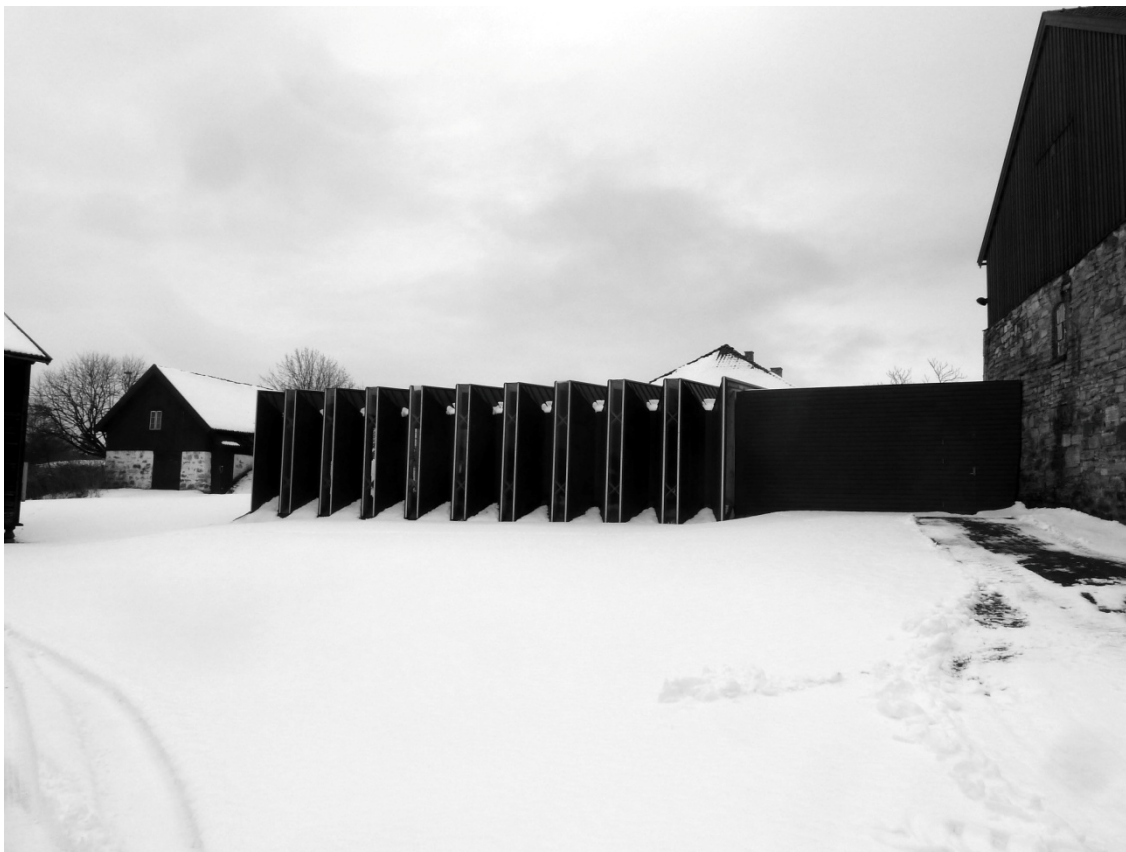
Fig.82: Vista de la fachada norte de la ampliación del Museo Hedmark. Invierno de 2015.
