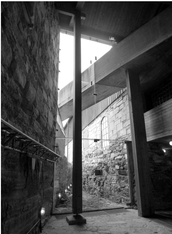
Figs.105 y 106: Imágenes del espacio triangular a triple altura con las rampas de hormigón sobrevolando el espacio y cruzándose entre sí a diferentes niveles. La rampa superior incluso sale del edificio hacia el patio. Es interesante el contraste entre verticalidad y horizontalidad marcado por la escalera helicoidal y el poste de madera que sostiene la cubierta, frente a las rampas de hormigón armado. Primavera de 2016.
