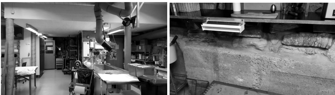
Figs.220 y 221: Vistas interiores del sótano de la magazine en la actualidad, donde trabajan los conservadores del Museo Hedmark. Se aprecia la brutalidad del encuentro de la nueva cimentación de hormigón armado con el terreno y el muro de piedra. Primavera de 2016.
