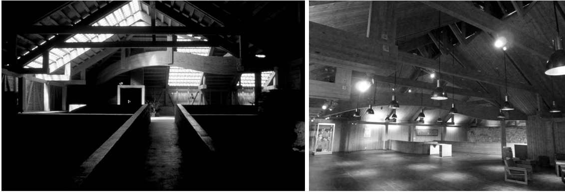
Figs.162 y 163: Imágenes de las dos esquinas que configuran la planta en forma de "U" del Museo Hedmark. En ambas se aprecia la viga curva de madera laminada que soporta la cubierta y que resuelve el encuentro de una crujía con la siguiente. Primavera de 2016.
