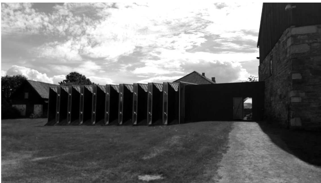
Fig.83: Imagen de la fachada norte del porche que sirve de conexión entre el edificio antiguo y su ampliación. Se observa la puerta abierta en el porche de madera. Primavera de 2016
