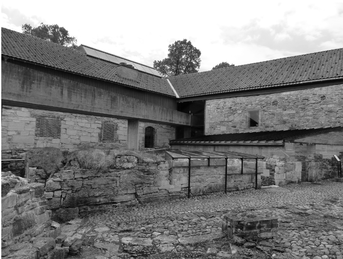
Fig.13: Perspectiva de uno de los restos de muro restaurados donde se aprecia la superficie vegetal en la coronación del muro para su protección frente al agua de lluvia. Primavera de 2016.
