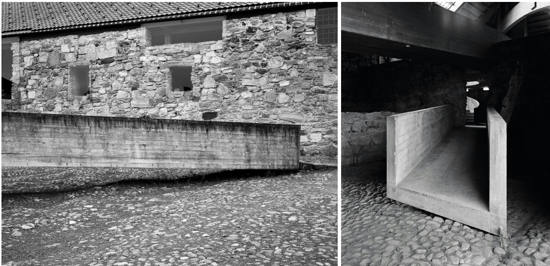
Figs.116 y 117: Vistas de la rampa exterior del patio y de la rampa interior del portón de acceso. Ambas imágenes señalan el corte que se produce entre la arquitectura y el terreno. En el caso de la rampa exterior, la transición parece algo más amable, ya que el terreno viene a buscar a la rampa a través de una piedra de grandes dimensiones, que sobresale con respecto al resto. Imágenes de Helen Binet publicadas en la revista Architecture Norway.
