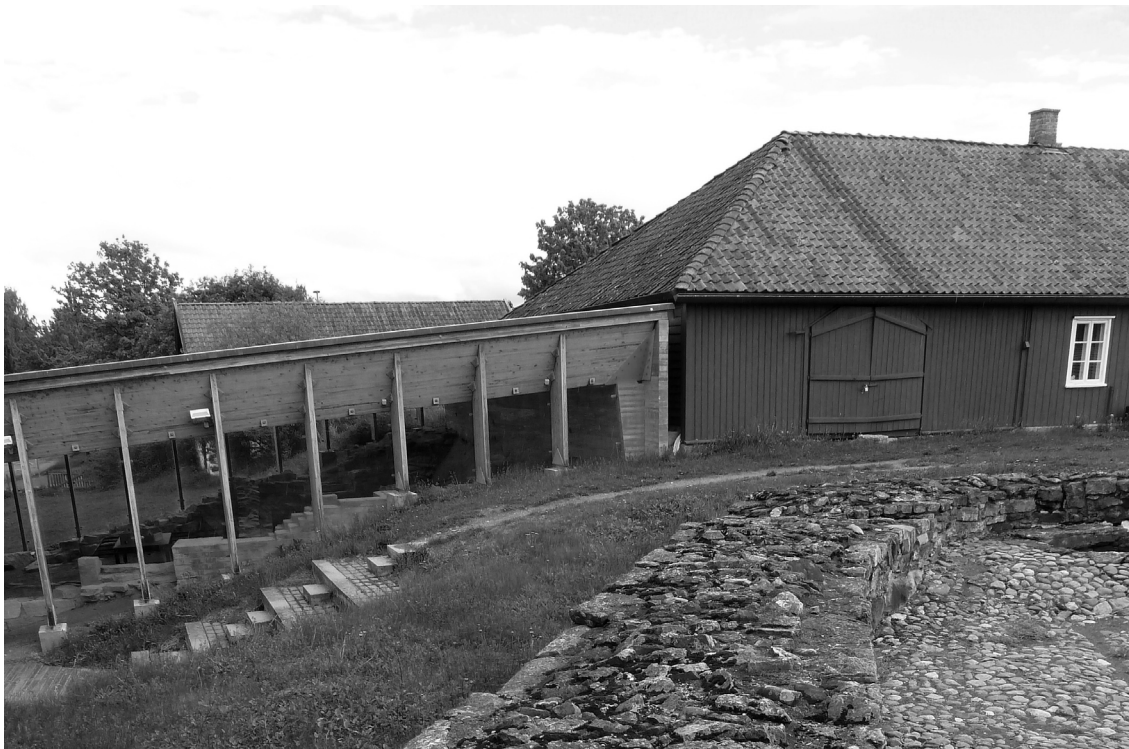
Fig.92: Imagen del nuevo pabellón protector de ruinas junto al edificio existente utilizado por los trabajadores. Se observa perfectamente cómo la nueva cubierta se queda inmediatamente por debajo del alero del edificio existente. Primavera de 2016.
