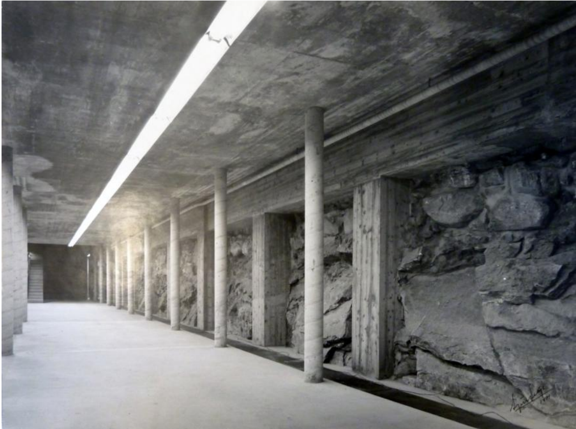
Fig.227: Vista del sótano de la magazine nada más acabada la obra en el año 1971. Nasjonalmuseet Arkitektur Fotoarkiv.
