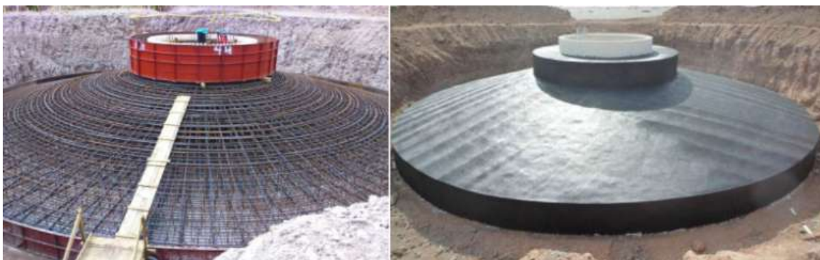
54. Irudia. Zimentazio prozesuaren bilakaera. https://www.c-harbor.com/proyectoseolicos/cimentacion-tik-berreskuratua
