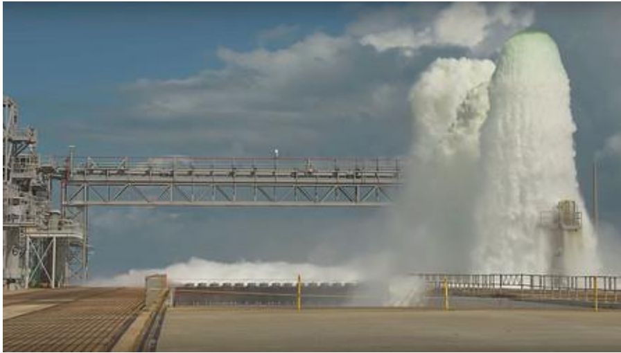
Figura 8. Utilización de agua en el deflector para reducir los efectos del sonido y el calentamiento.
