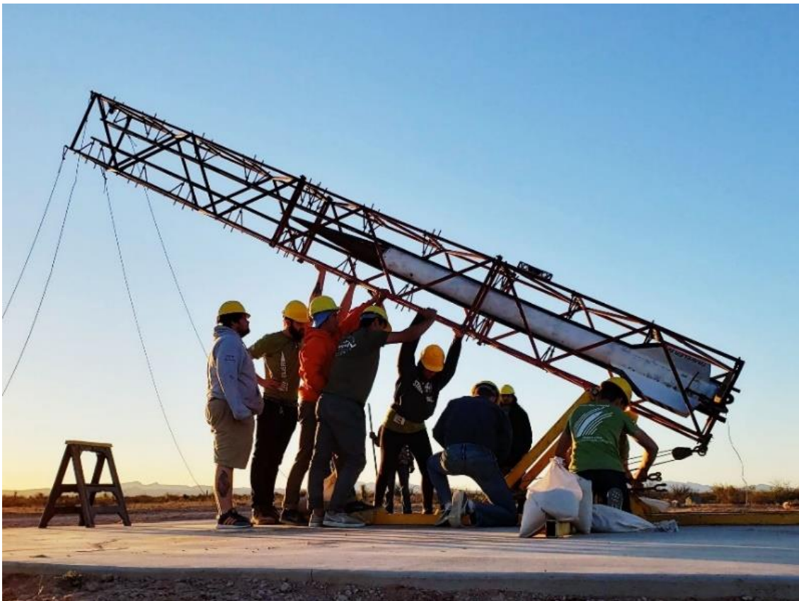
Figura 14. Plataforma del equipo de USC.
