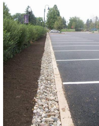
6. Irudia. Infiltrazio-zanga Lancaster-ren, Erresuma Batua. Iturria: cityoflancasterpa.com
