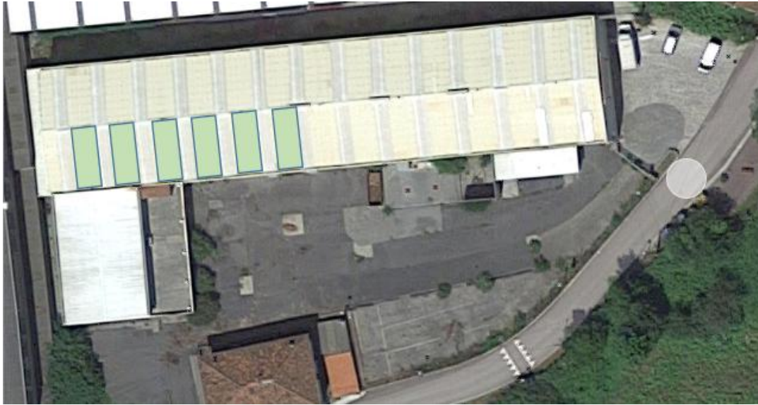
Figura 1.5 Disposición de los paneles en la cubierta
