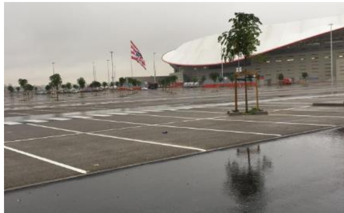
Irudia 20: Zoladura iragazkorra Wanda Metropolitano estadioan (Madril). Iturria: Madrilgo udaletxea
