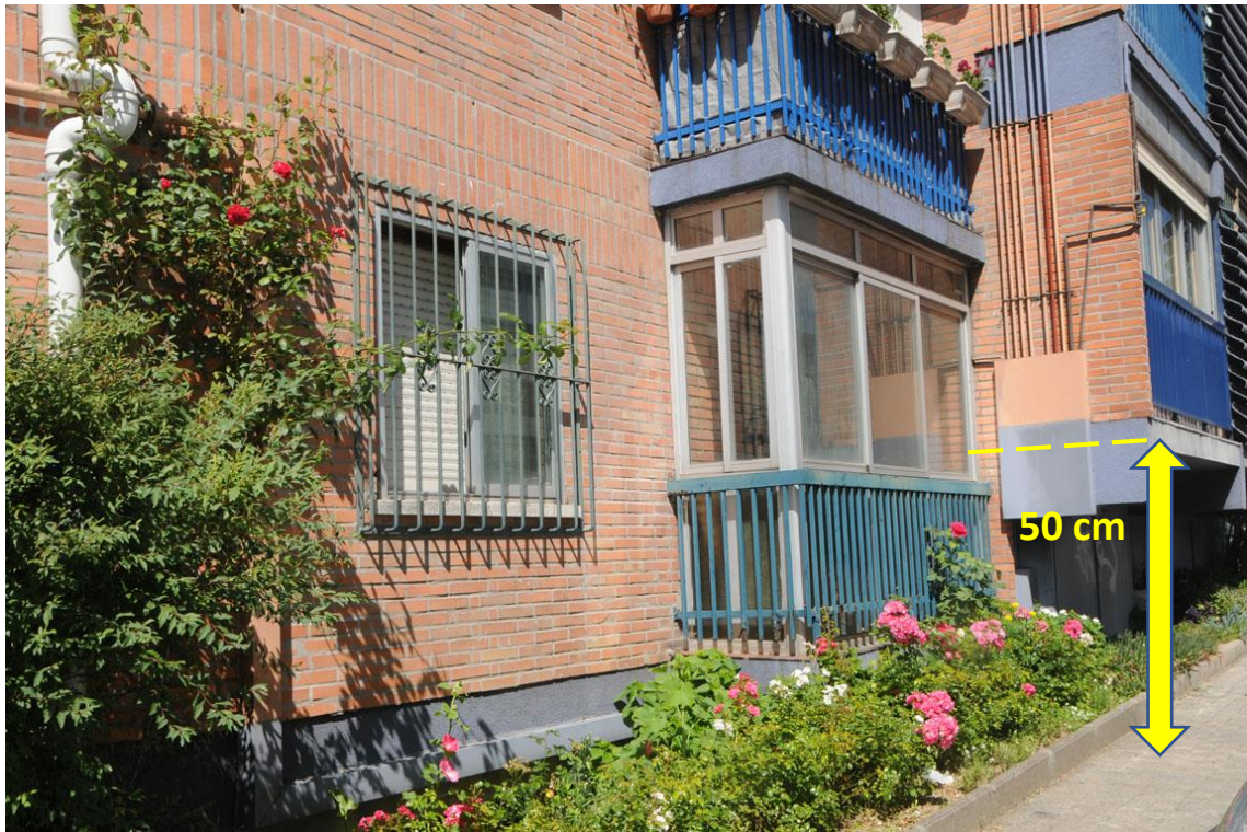
Fotografía nº1.- Vista parcial de la fachada donde se ubica el balcón, por el que presuntamente accedió el autor de los hechos denunciados.
