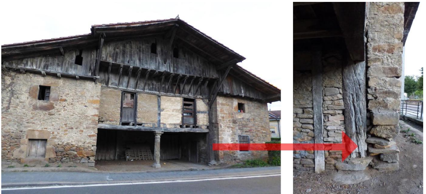
4.9. irudia. Luiaondoko Baserria (Aiara) eta barruko zurezko egituraren xeheetasuna.
