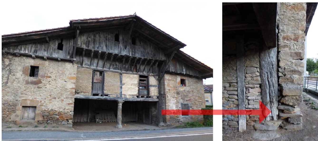
Figura 4.9. Caserio en Luyando (Aiara) y detalle de la estructura de madera interior.
