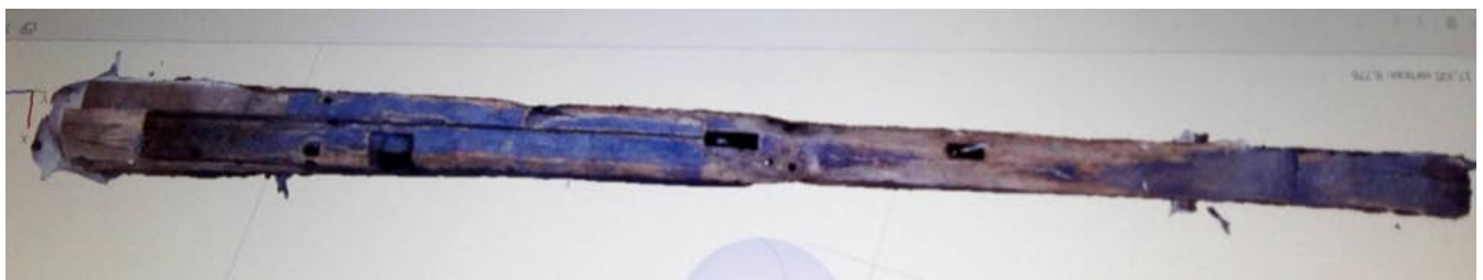
3.2. irudia. Garaikoetxea Baserriaren (Alkiza) zurezko zutoina, fotogrametria bidez jasoa.
