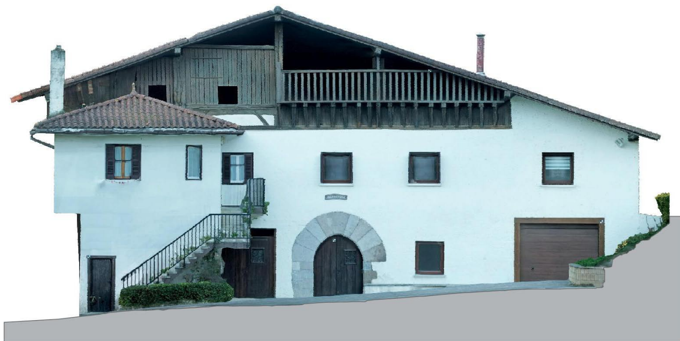
Figura 6.16. Fachada del Caserío Berastegi (Zizurkil), realizada por Javier Perez para Arkeolan.
