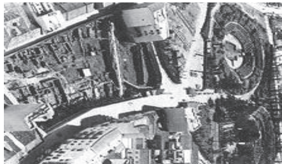
Solar antes de la construcción y
