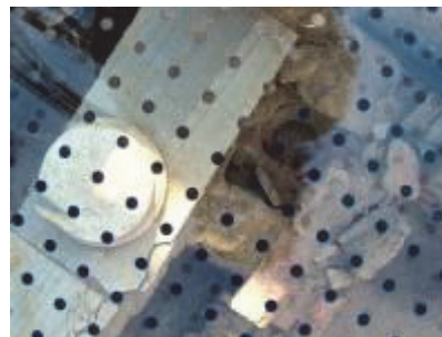
Vista de las ruinas a través del cristal del pavimento exterior. Los puntos negros tienen la función de filtrar la luz natural
