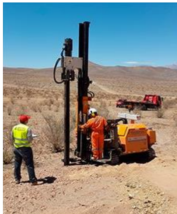
Imagen 13 – Maquinaria para hincar directamente un apoyo de la estructura
