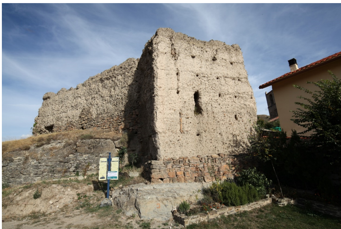
Fig. 1. Fotografía de parte del alzado exterior de la muralla Norte del Castillo de Enciso.
