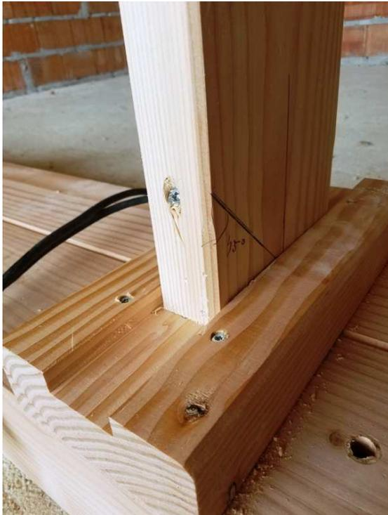
*Imagen 6: Zapata fresada anclada a la durmiente mediante 4 tirafondos.*
