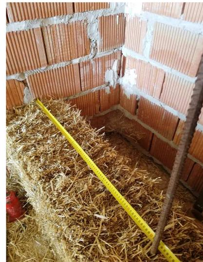
Imagen 8: Medición y marcado para recosido de fardos.
