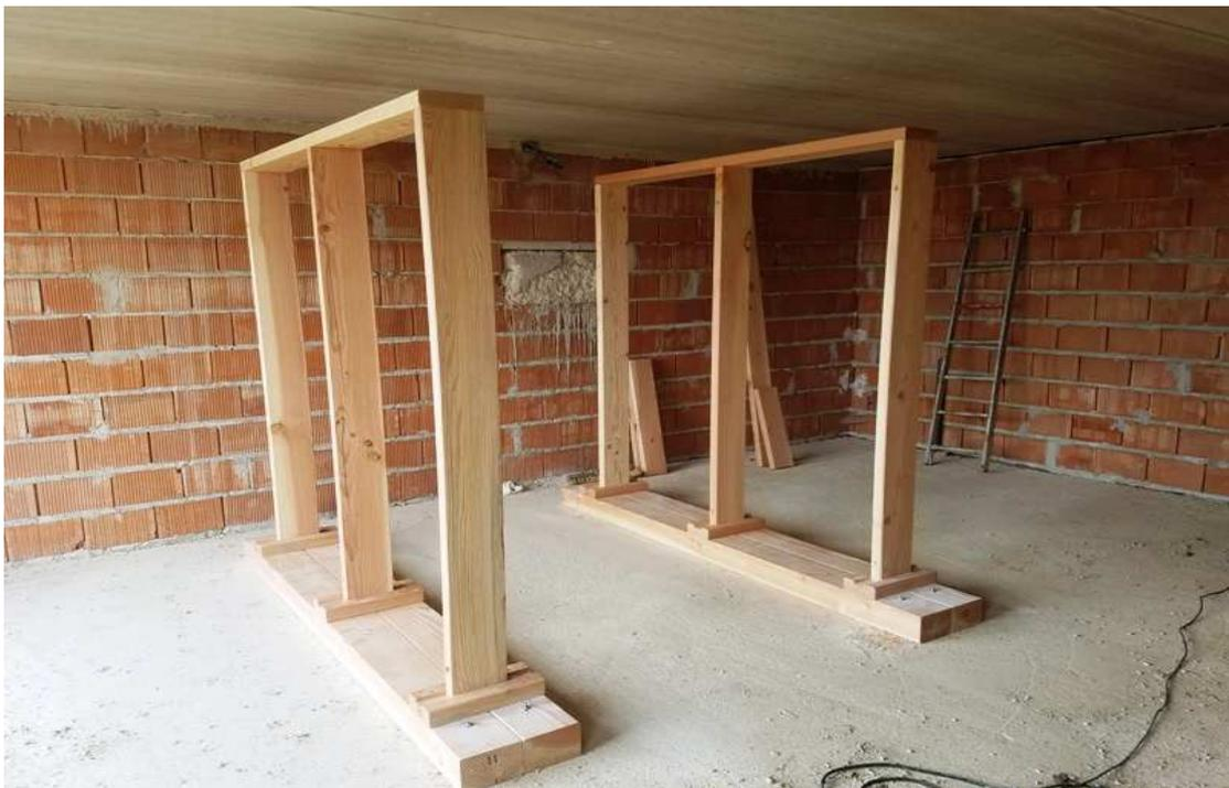
*Imagen 11: Bastidores de Módulo A y Módulo B, en construcción. .*
