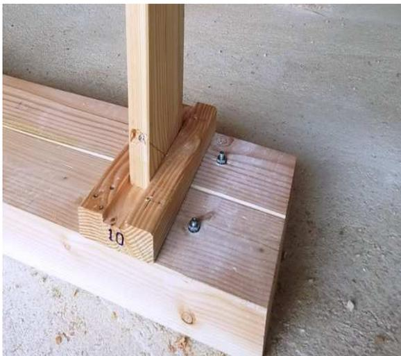
*Imagen 1: Anclaje de durmiente sobre losa de cimentación.*
