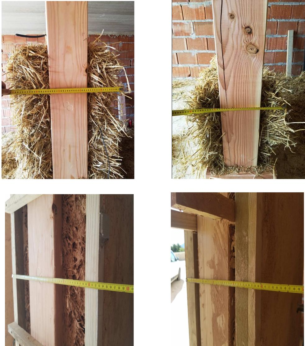
*Imagen 22: Espesores antes y después del revestimiento.*
