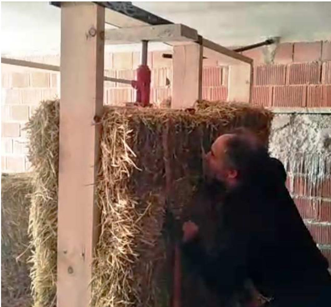
*Imagen 12: Cinchado de fardos, solo para mantener la tensión aportada por los gatos.*
