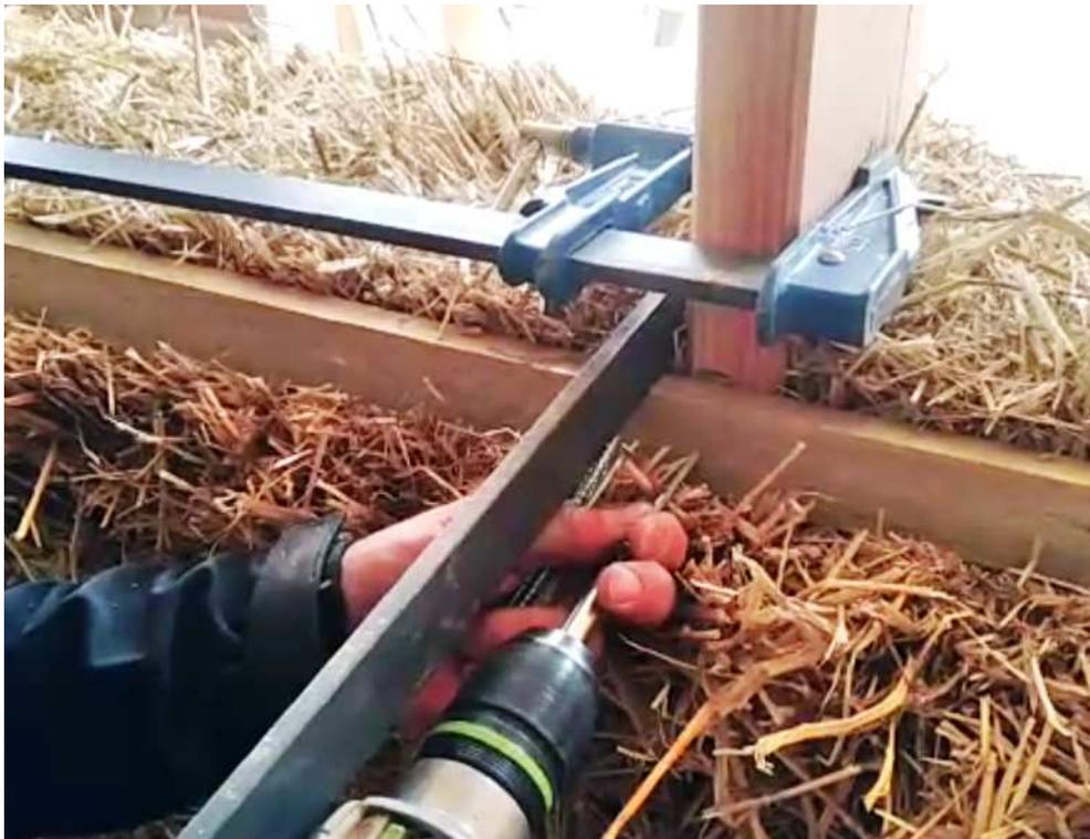
*Imagen 19: Se hace palanca con un perfil metálico para comprimir el fardo 1cm en vertical.*
