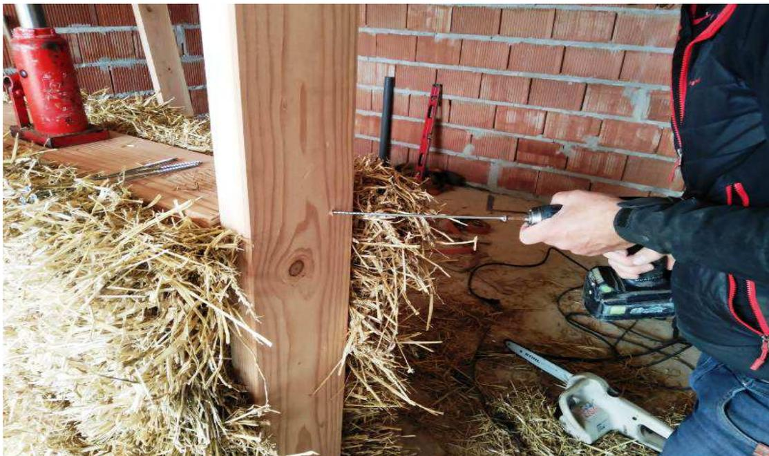
*Imagen 11: Fijación de travesaño horizontal.*
