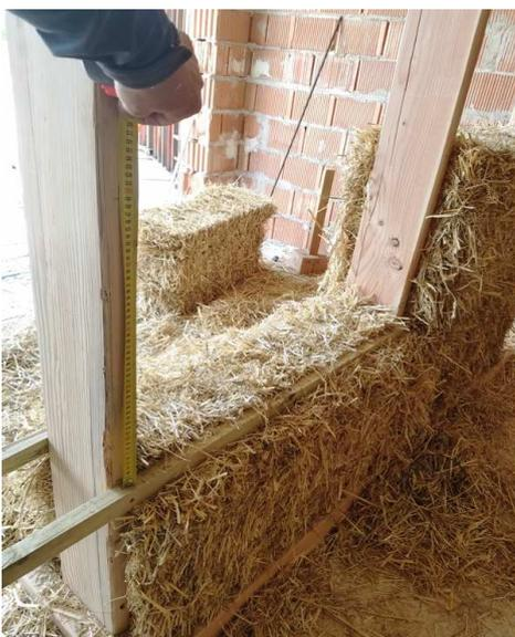
Imagen 16: Montaje por hiladas.
