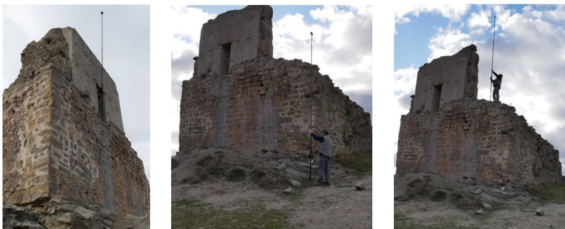
Fig. 1 Ubicación de la cámara en distintas posiciones con jalón telescópico y accionamiento remoto.
