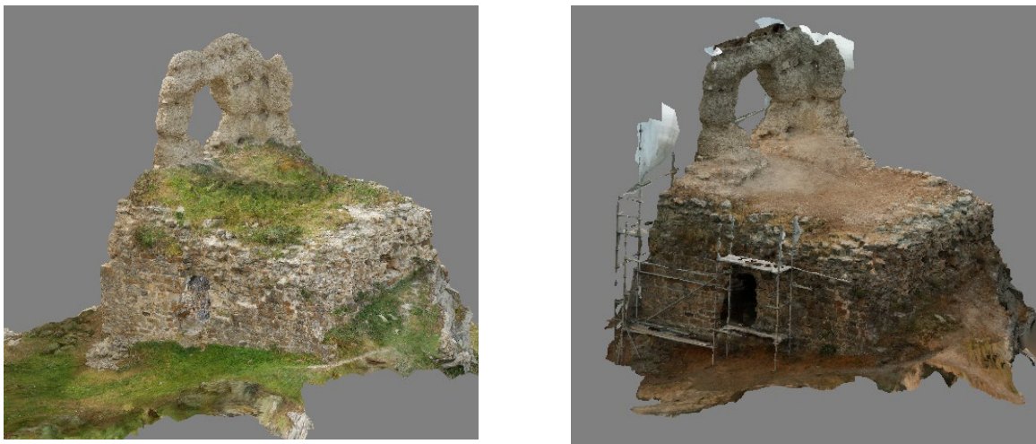
Fig. 11. A la izquierda modelo del 28 de mayo en el que la superficie superior del torreón está cubierta de vegetación. A la derecha modelo del 14 de agosto en el que aparecen andamios, pero a superficie superior está limpia.
