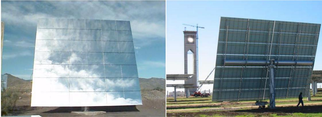
Figura 2.7 Heliostato de la PS10. Frontal (Téllez et al., 2014), trasera (Inabensa et al., 2006)
