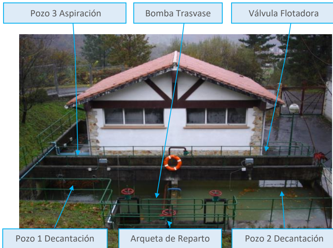
Figura 13. Instalaciones del proceso de fangos.
