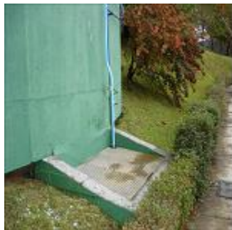
Figura 17. Válvula y conducción de la purga de fondo.
