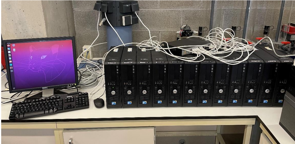
Figura 7.23 Equipos Empleados para la Prueba
